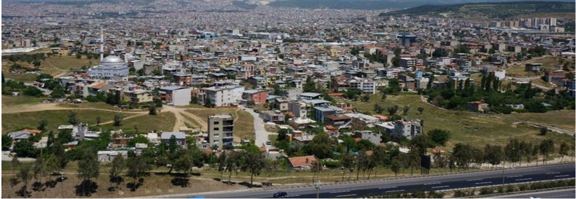
Resim 5.11. Gazimur ilçesi Aktepe Emrez kentsel dönüşüm ve gelişim alanının genel görünümü (İzmir Büyükşehir Belediyesi Kentsel Dönüşüm Dairesi arşivi, 2024)
