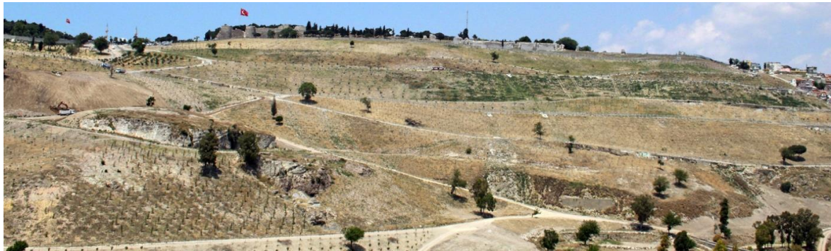
Resim 5.8. Kentsel yenileme projesi sonrası tarihi Kadifekale'nin 'afete maruz bölge' ilan edilen güney yamacı (İzmir Büyükşehir Belediyesi Kentsel Dönüşüm Dairesi arşivi, 2024)
