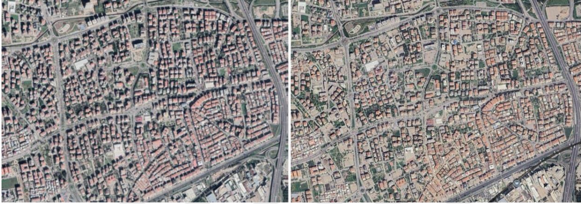
Harita 5.60. Bayraklı ilçesi Manavkuyu bölgesinin 30 Ekim 2020 tarihinde meydana gelen depremden önceki (solda) ve sonraki (sağda) durumu (İzmir Büyükşehir Belediyesi İmar ve Şehircilik Dairesi arşivi, 2024)
