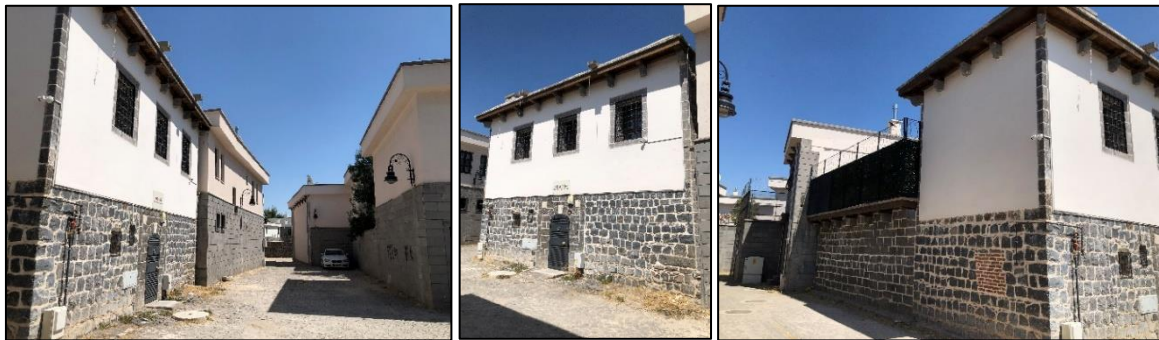
Resim 4.8. 23 ve 14 numaralı parsellerin boşaltılması sonucunda oluşan sokak dokusu ve tescilli yapı görselleri
