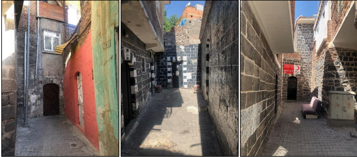
Resim 2.4. Geleneksel Diyarbakır kent dokusuna ait çıkmaz sokak görselleri (yazar arşivinden)
