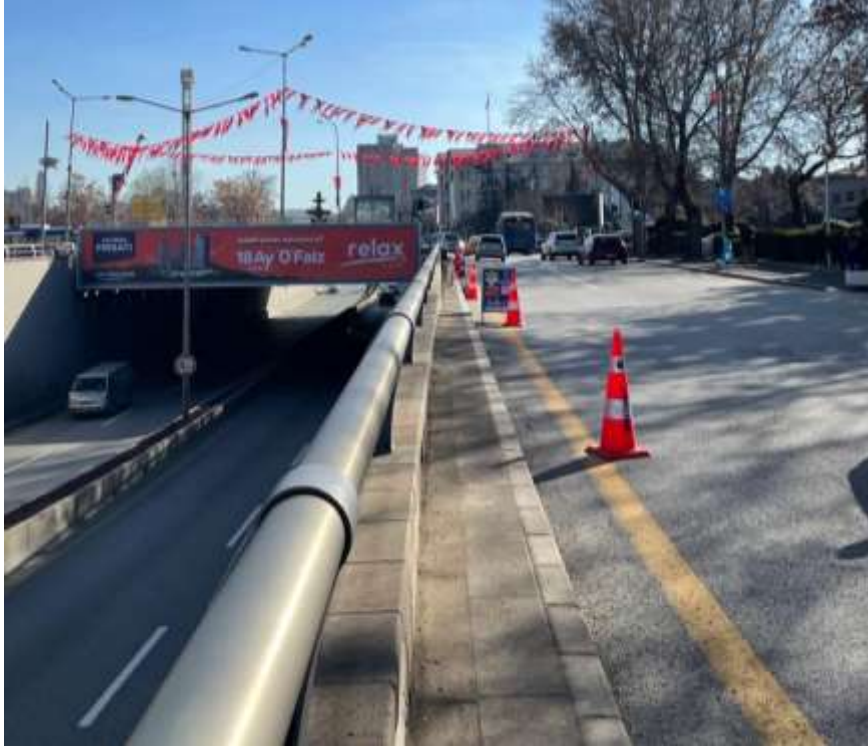
Resim 4.65. Ankara Gar Meydanına inşa edilen altgeçit
