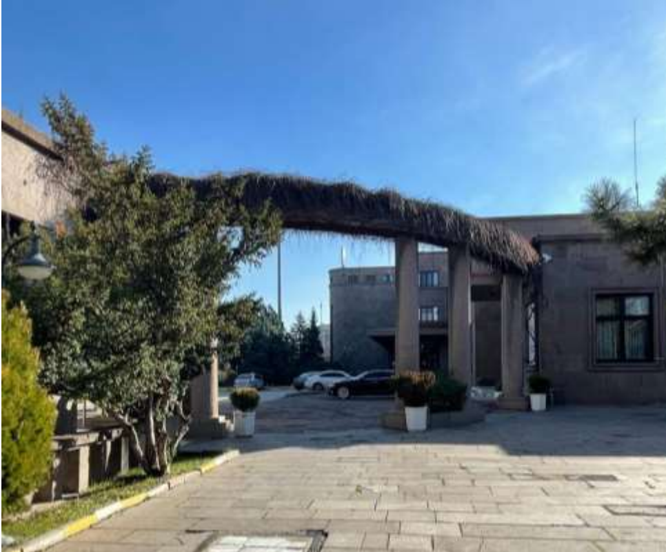
Resim 4.41. Gar Gazinosu ile Gar binası arasındaki bağlantı elemanı
