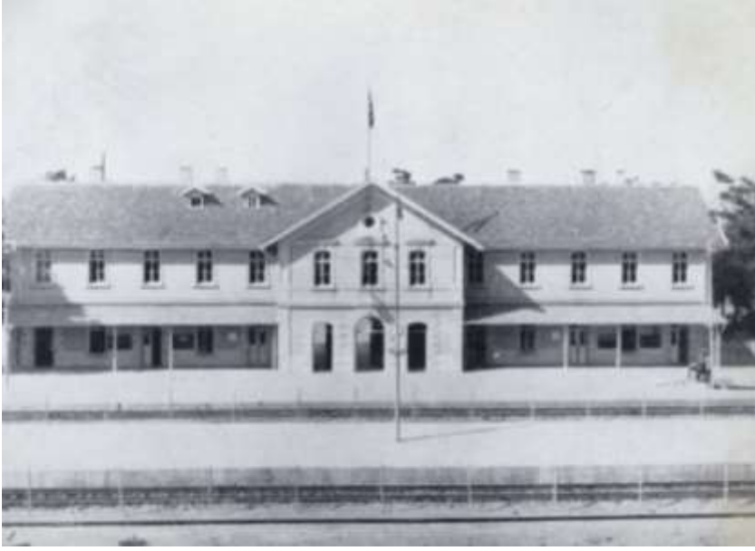
Resim 4.2. Eski istasyon binası demiryolu cephesi (SALT Araştırma, Fotoğraflarla Yeni Ankara Garı, Env. No: ABK00258)
