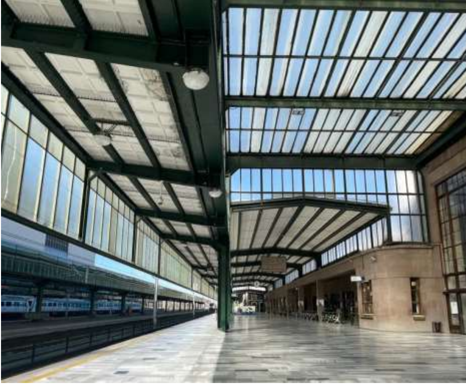
Resim 4.38. Ankara Tren Garı demiryolu cephesi
