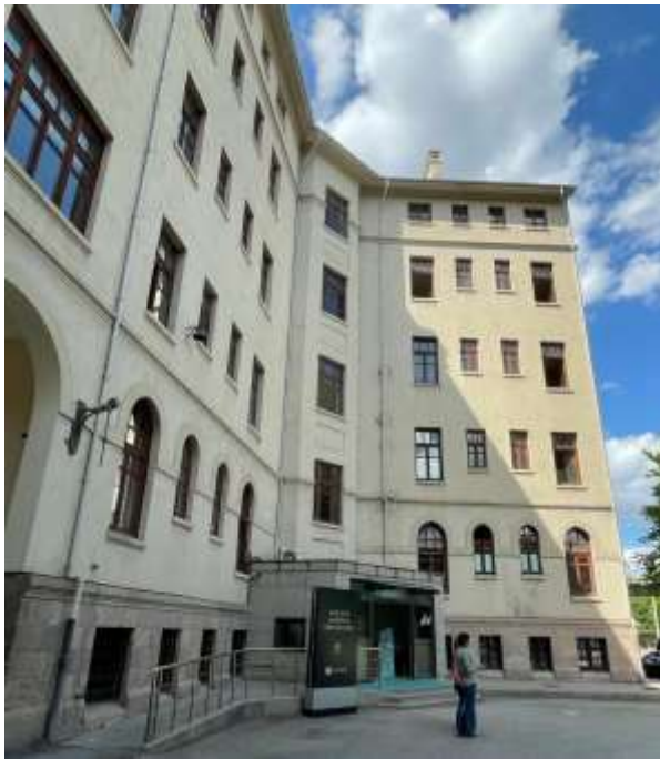
Resim 4.29. TCDD II. Bölge Binasının doğu cephesinde bulunan girişi
