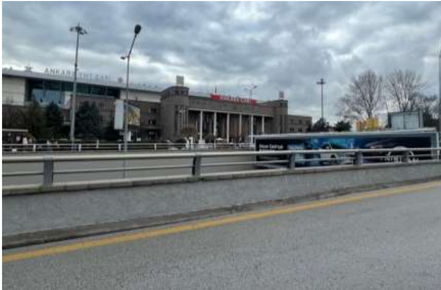
Resim 4.66. Ankara Gar Meydanına inşa edilen altgeçit
