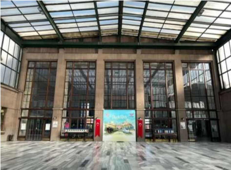
Resim 4.37. Ankara Tren Garı demiryolu cephesi
