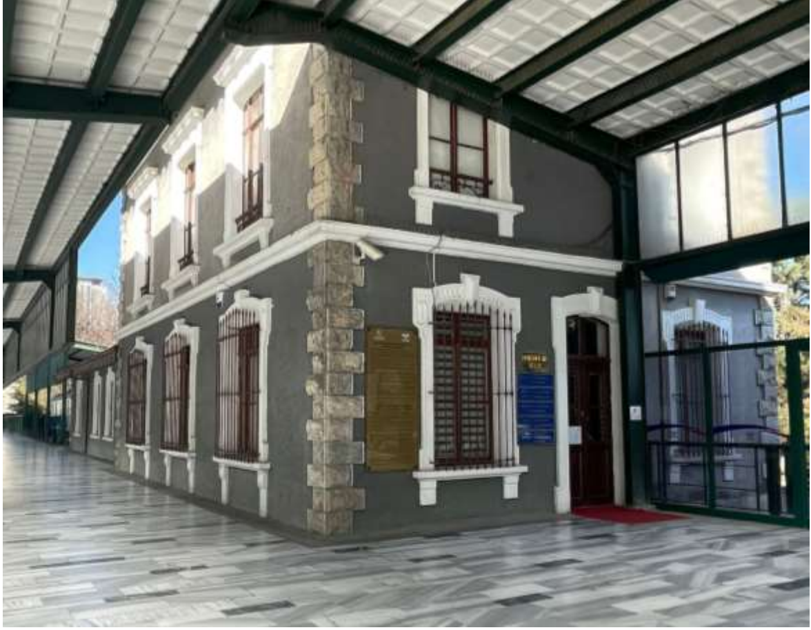
Resim 4.20. Atatürk Konutu ve Demiryolları Müzesi demiryolu cephesi
