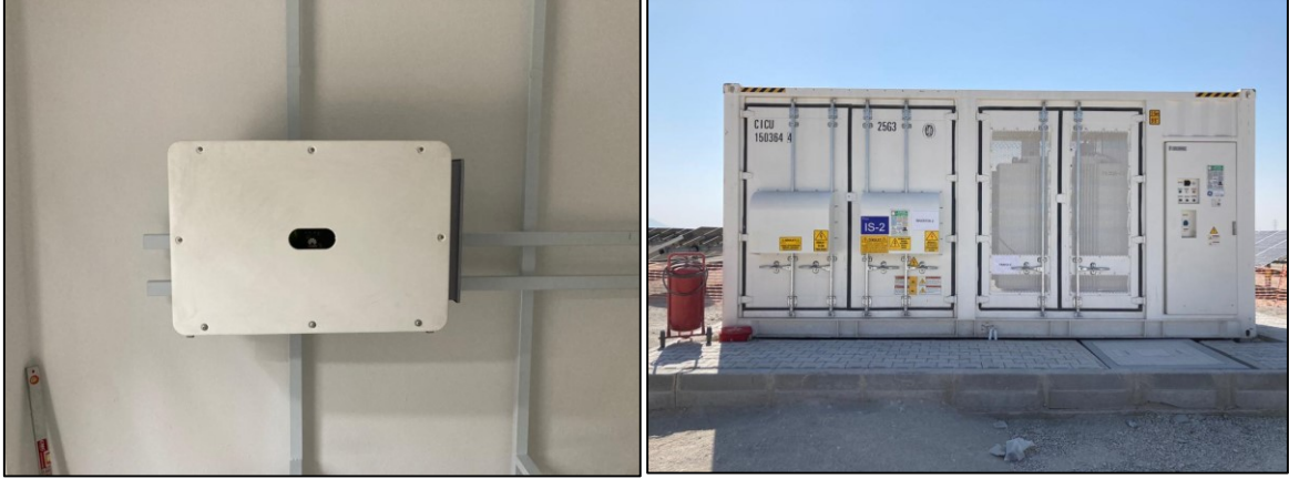
Şekil 3.13. İki farklı evirici (inverter)
