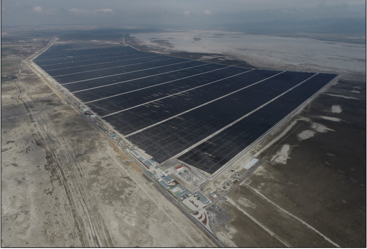
Şekil 4.2. Konya, Karapınar, YEKA-1 GES, faz-1 drone görüntüsü
