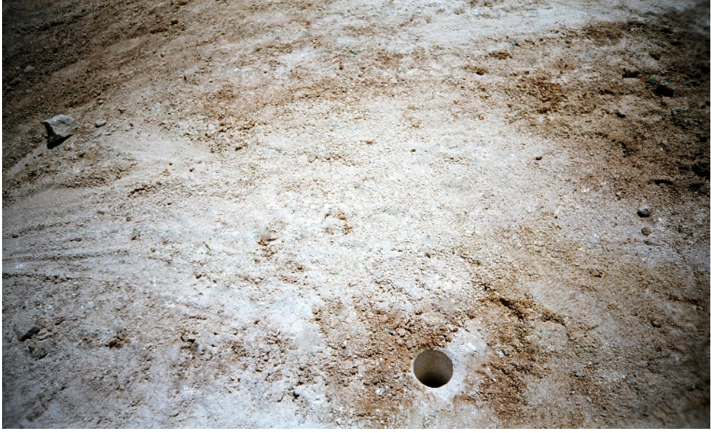
Resim 19.1. Pnömatik delici ile açılan delik
