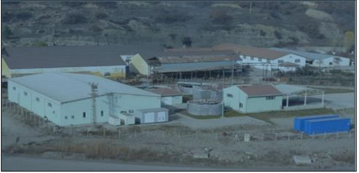
Resim 3.4. GLİ arıtma tesisi görseli [49]
