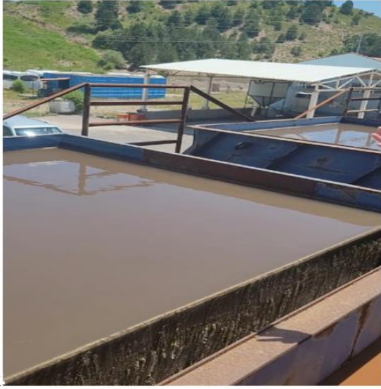
Resim 3.10. Lamella ünitesi fotoğrafları
