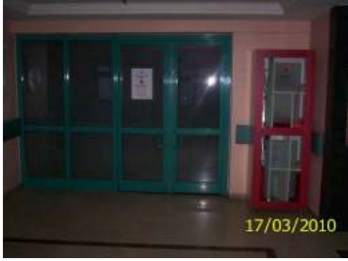
Resim 4.20. İç kaçış koridoru kapısı
