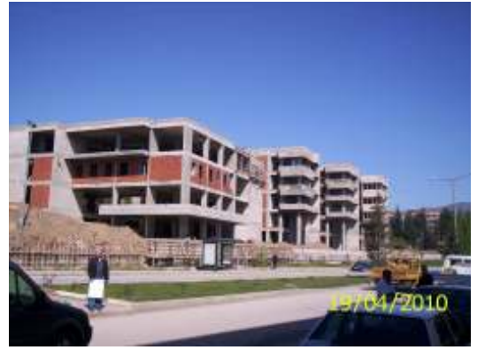
Resim 4.23. Morfoloji binası güney doğu görünüşü
