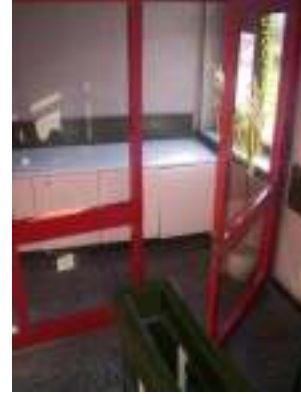
Resim 4.17. C blokta kaçış merdiveni kapısı açık görünüşü
