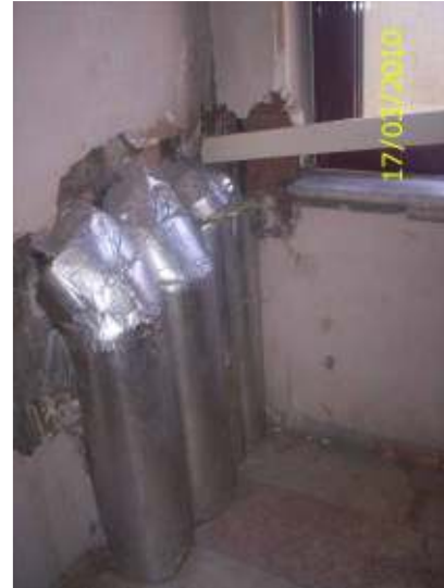
Resim 4.11. D1 bloktaki tesisat kanalının yakın görünüşü
