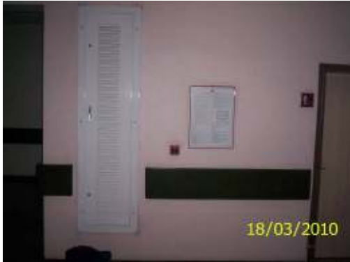
Resim 4.12. Tesisat shaftı kapağı
