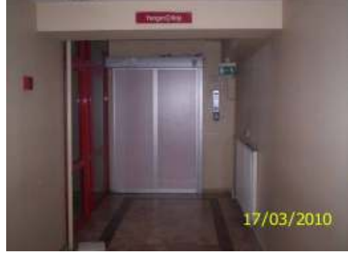
Resim 4.19. Kaçış merdiveni kapısı kilitli durumda
