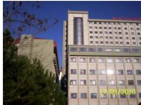
Resim 4.15. Giydirme cephe olan bölümün dıştan görünüşü
