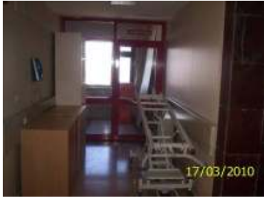
Resim 4.16. D1 blokta kaçış merdiveni giriş kapısı önü
