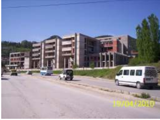
Resim 4.22. Morfoloji binası kuzey doğu görünüşü
