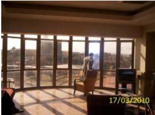
Resim 4.14. Giydirme cephe olan içinden görünüş mekanın
