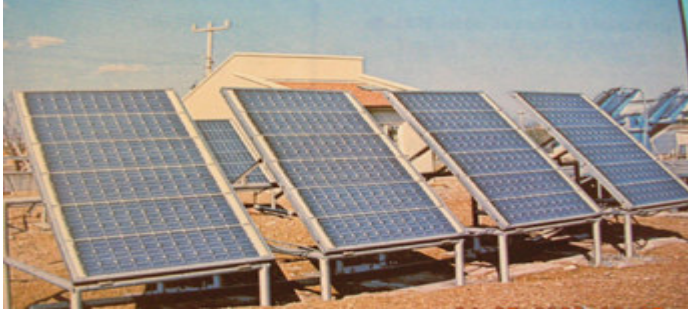
Resim 4.3. Güneş pili sistemi [44]
