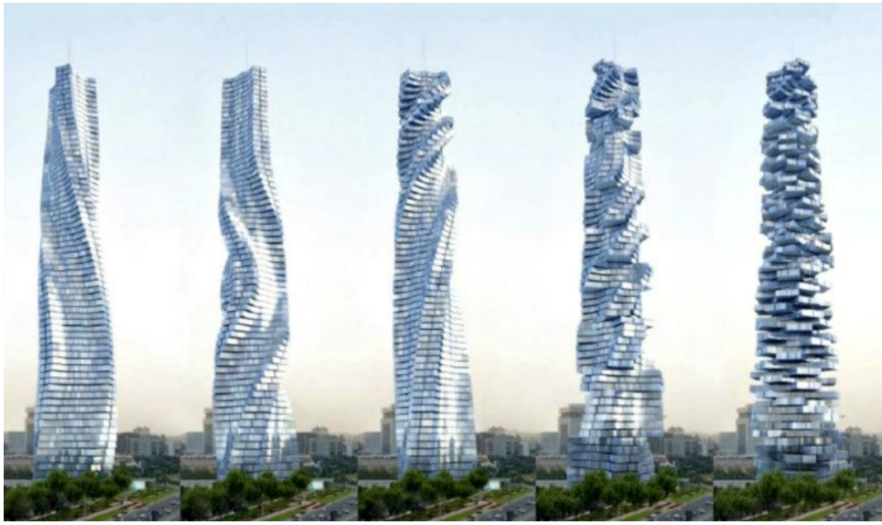
Resim 3.45. Dynamic Tower kat modüllerinin hareketleri [128]
