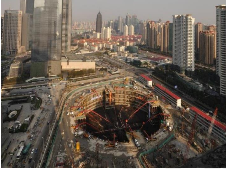
Resim 4.6. Shanghai Kulesi temel sağlamlaştırma çalışması [29]
