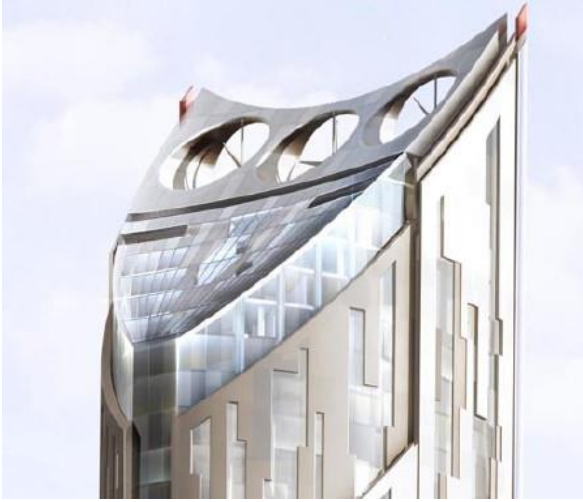
Resim 3.42. Tepe noktasına konumlandırılmış türbinler ve konkav form [118]
