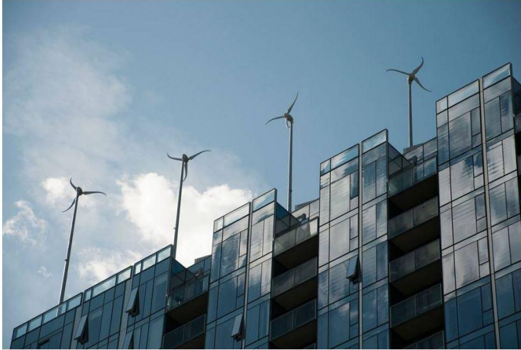
Resim 2.9. Konut sahipleri tarafından kullanılan yapının üzerindeki bina monte rüzgar türbinleri Portland, Amerika. 2012 [36]
