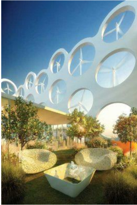
Resim 3.49. Cor Florida Tower cephe yüzeyinde yer alan rüzgar türbinleri [131]
