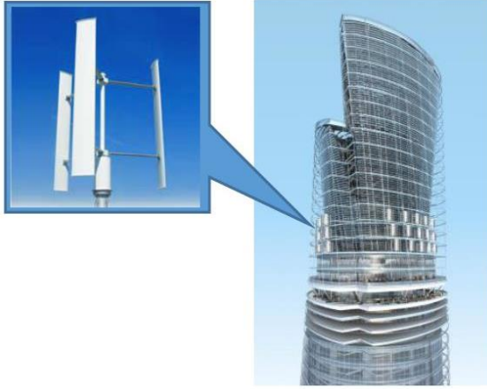
Resim 4.14. Kulenin bitiş parapetine yerleştirilen rüzgâr türbinleri [134]
