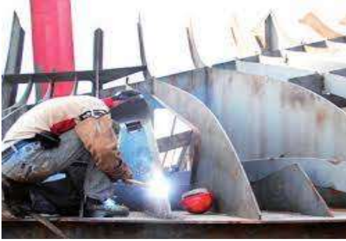
Resim 3.3. Alt blok üretim aşamaları (İnternet: MEGEP, 2016)
