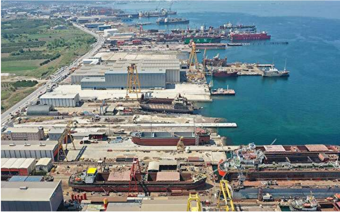
Resim 3.1. Altınova tersaneler bölgesi (İnternet: Yalova Altınove Tersane Girişimcileri, 2022)
