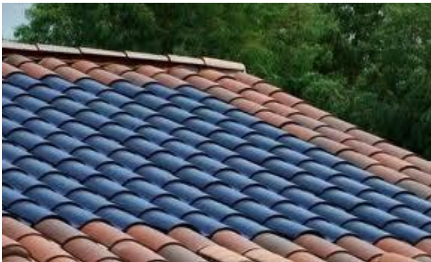
Şekil 3.3. Çatı ile bütünleşik fotovoltaik sistem ( www.curiousengineers.wordpress.com )
