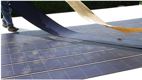
Şekil 2.8. İnce Film Fotovoltaik hücre (İnce film güneş paneli nedir, 2018)
