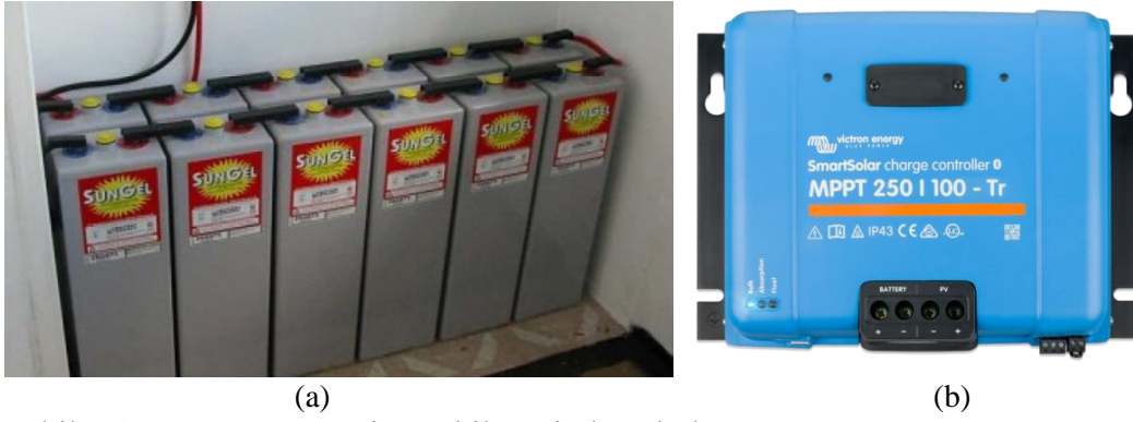
Şekil 2.4. (a)Fotovoltaik sistem bileşeni olan aküler (b)şarj denetim birimi (www.tesisat.org, 2018)
