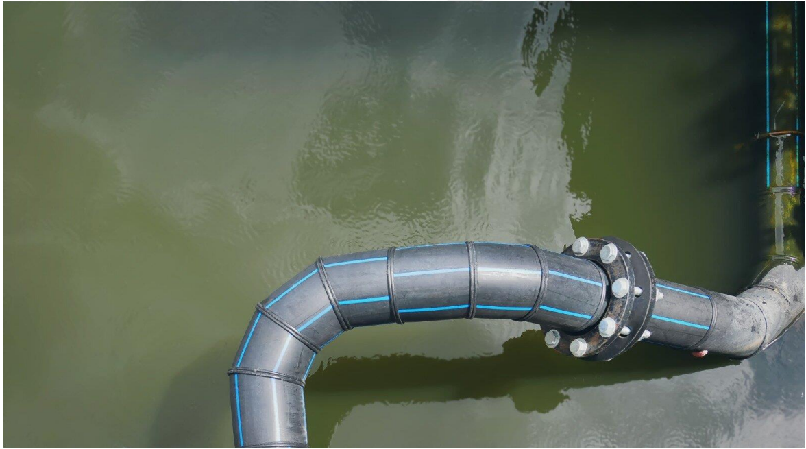
Resim 5.2. Çoklu dönüş ve ek yeri içeren bir polietilen boru
