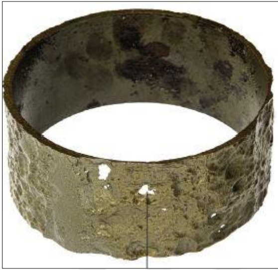
Resim 5.3. Korozyona uğramış döküm boru [6]
