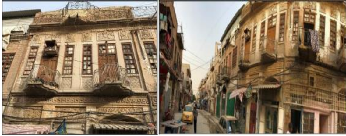
Resim 3.36. Araştırmacı tarafından alınan Alaa ALHADITHY konutu cepheleri.
