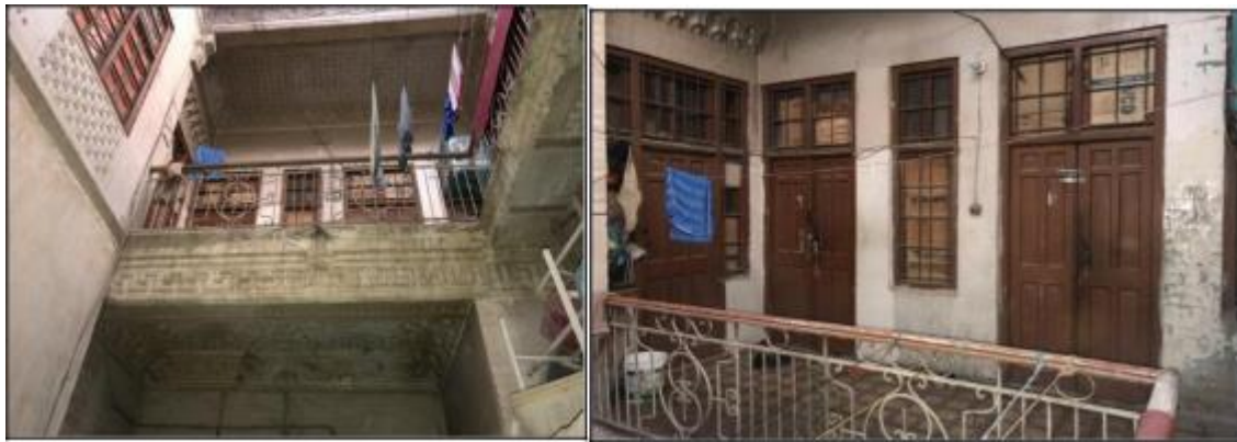
Resim 3.37. Araştırmacı tarafından alınan Alaa ALHADITHY konutu cepheleri.
