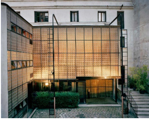
Resim 3.29. Maison de Verre bina girişi (URL-11)
