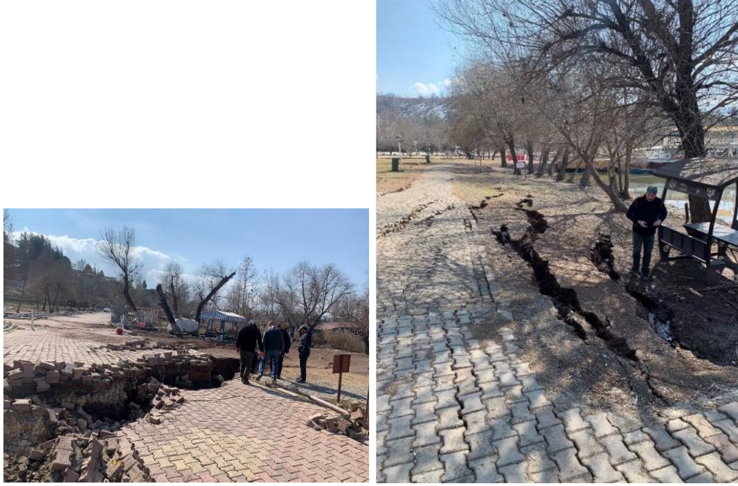
Resim 3.4. Gölbaşı Gölü'nün kenar kesimlerinde gözlenen yatay ve düşey zemin deformasyonları (G.Ü., 2023)
