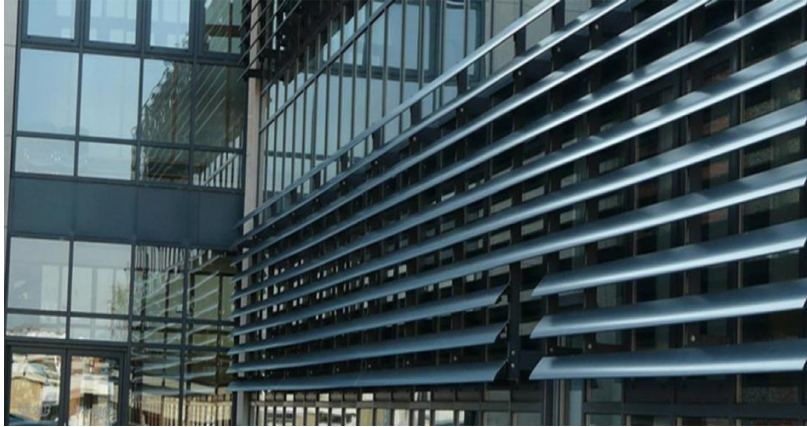
Resim 4.7. Yapının güney cephesinde uygulanması önerilen hareketli yatay alüminyum güneş kırıcı elemanlar (URL-53)
