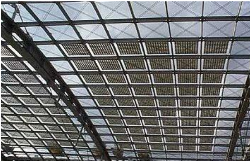
Resim 2.6. Yarı geçirgen fotovoltaiik panellerin atriyumda kullanımı (Yücel, 2016)
