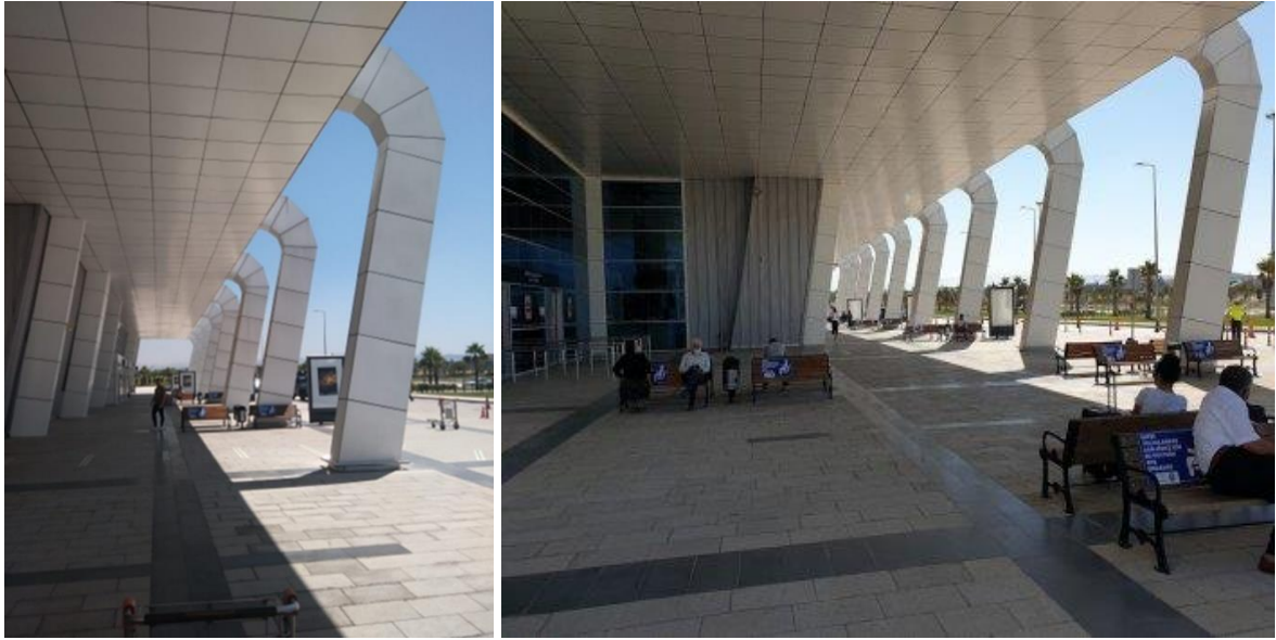
Resim 4.6. Yapı güney cephesinde konumlanan saçak (URL-52)
