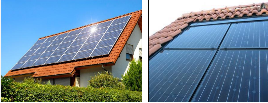
Resim 2.5. Eğimli çatıda PV panellerin çatı kaplaması olarak kullanımı (Yücel, 2016)
