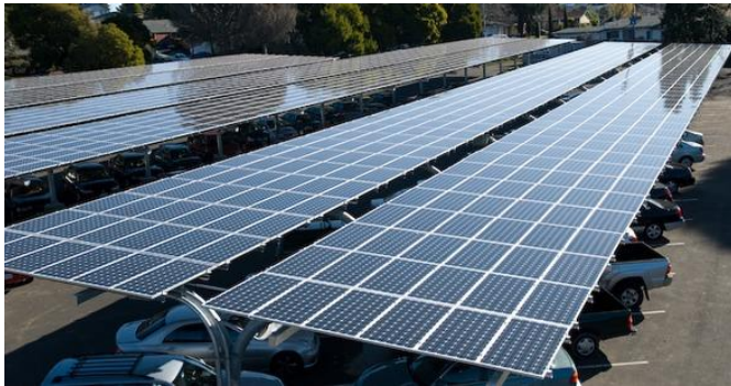
Resim 4.10. Açık otopark alanlarında PV panellerden oluşan üst örtü önerisi (URL-57)
