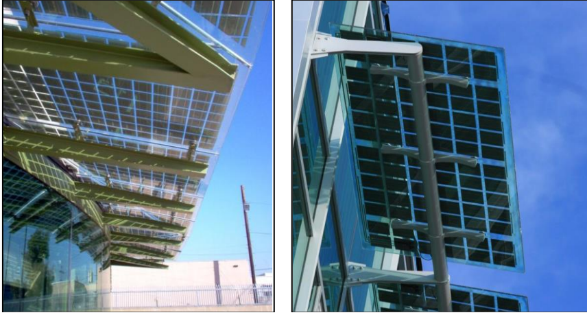
Resim 2.4. Fotovoltaik panellerin sabit ve hareketli gölgeleme elemanı olarak kullanımı (Cer, 2015)
