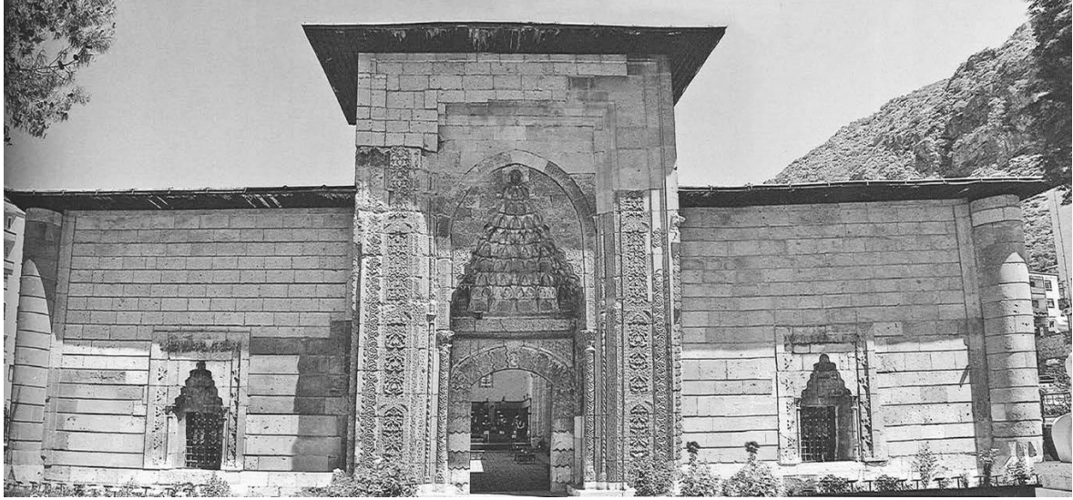
Resim 4.25. Darüşşifa giriş cephesi (Kılıç, 2012)
