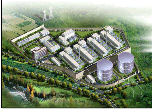
Resim 6.1. Sihe elektrik santrali
