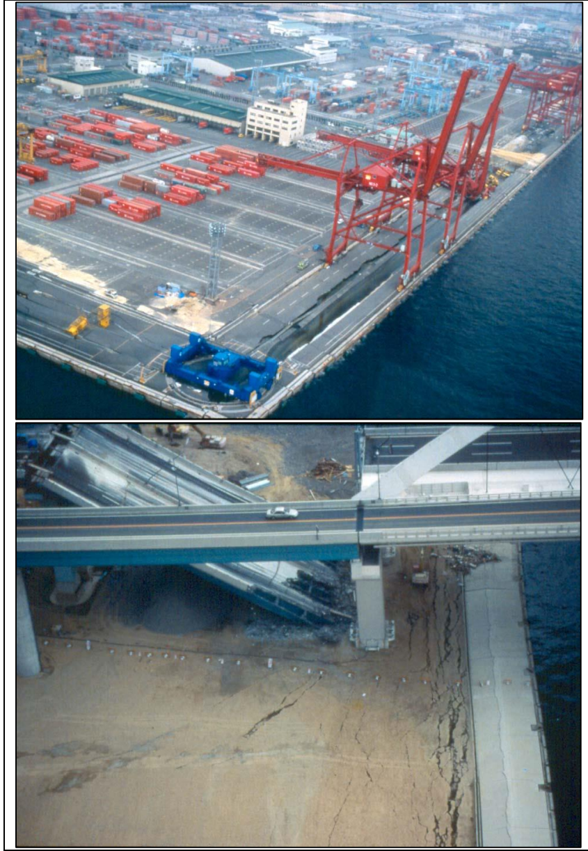
Şekil 2.14. Kobe depremi sonrası meydana gelen sıvılaşma ve hasar gören yapılar
