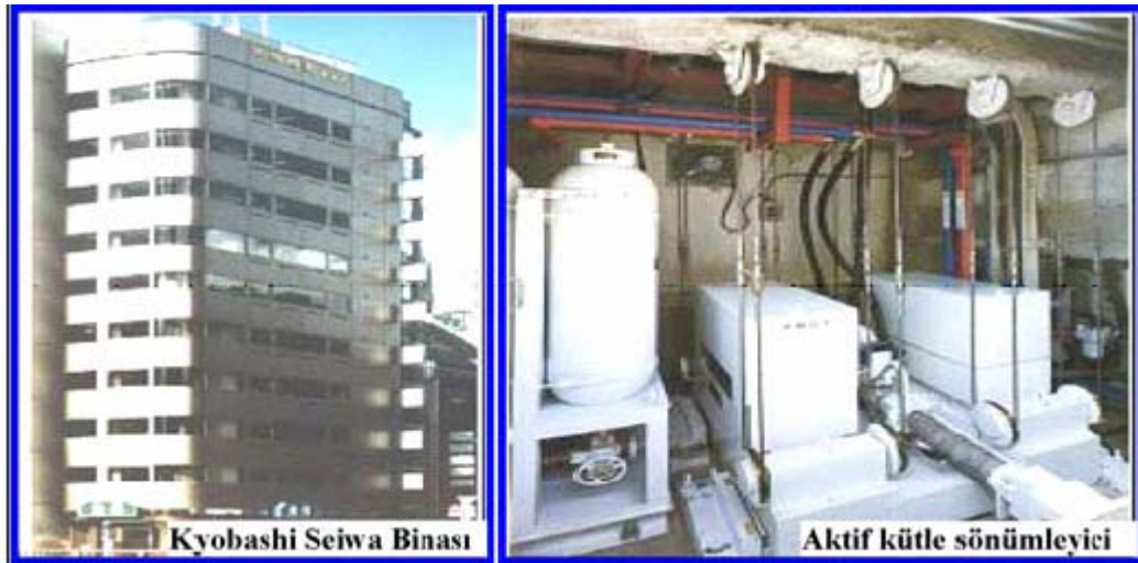
Resim 2.5. Aktif kütle sönümleyici sistem uygulaması.
