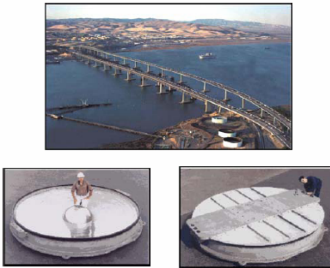
Resim 2.2. Sürtünmeli sarkaç sisteminin uygulaması (San Francisco, ABD) .
