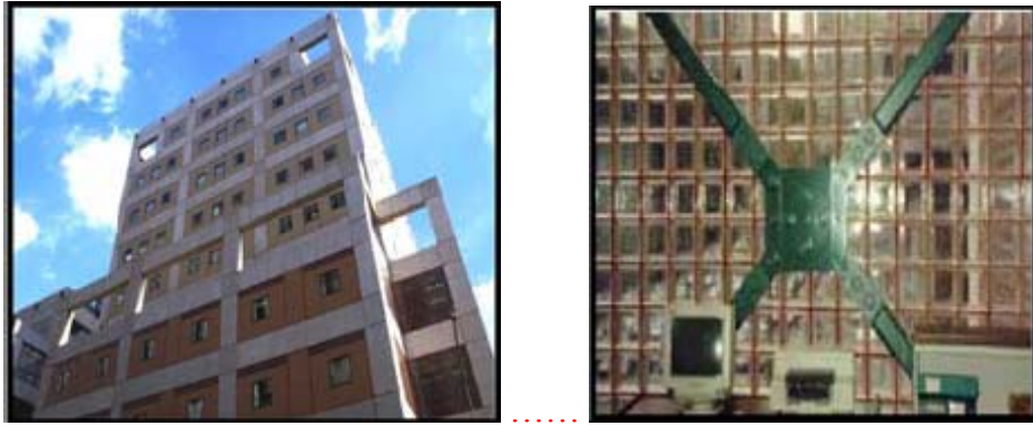
Resim 2.3.Pall tarafından geliştirilen sürtülmeli sönüm cihazı uygulaması .
