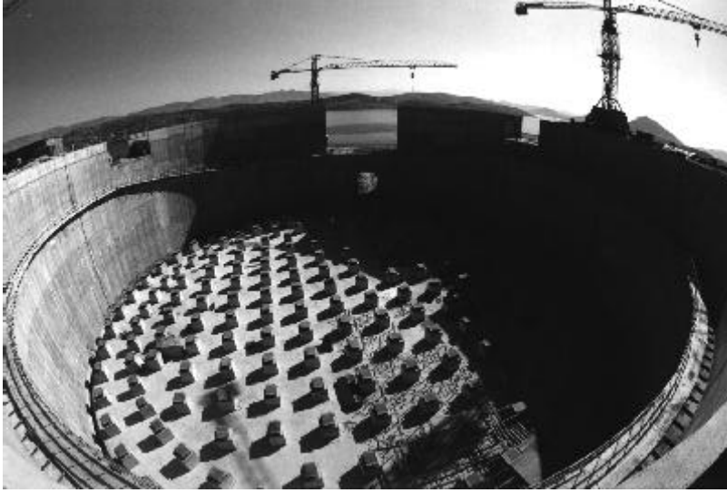
Resim 3.4. Yunanistan'daki sıvılaştırılmış doğalgaz tankı yapım aşamasında
