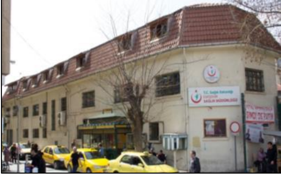
Resim 2.10. Solda: Eskişehir İl Sağlık Müdürlüğü Hizmet Binası (1915), (Üstün ve Köksal, 2016 ).
