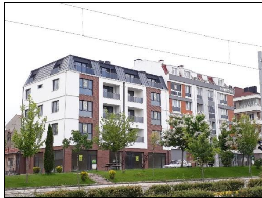
Resim 2.12. Eskişehir’deki mansard çatı örneği soldan sağa (a) bitişik parsel (b) köşe parsel
