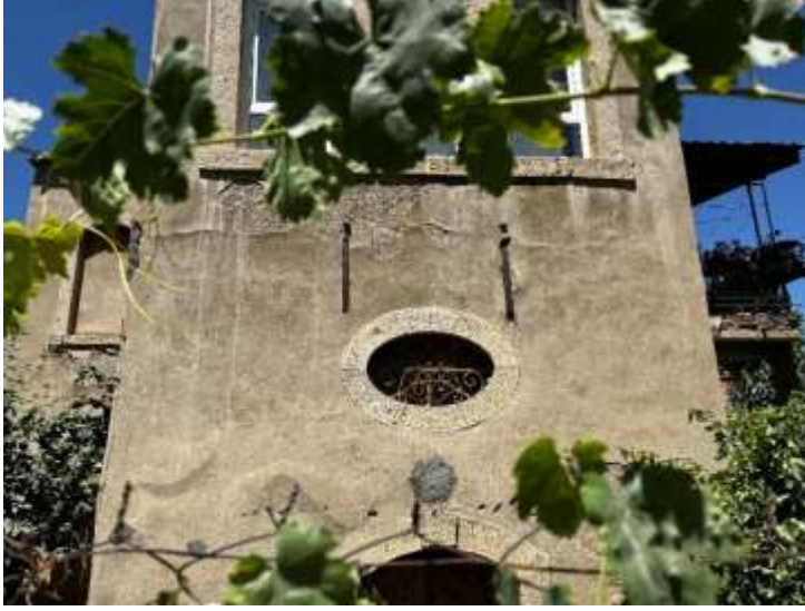
Resim 6.18. Tuncer Öz evi arka cephesi eliptik pencere
