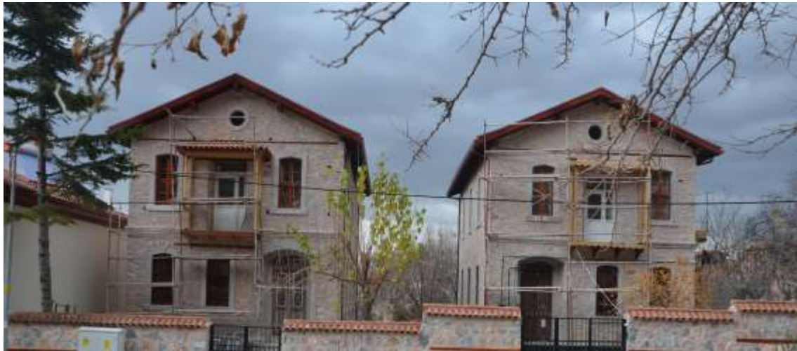
Resim 5.132. Güldane Sandıklı evi ve ikizi ön cephesi restorasyon aşaması
