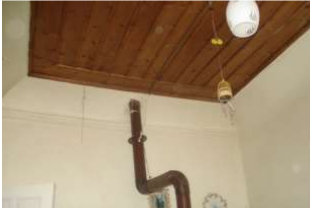
Resim 5.46. Birinci kat oda tekne tavan detayı
