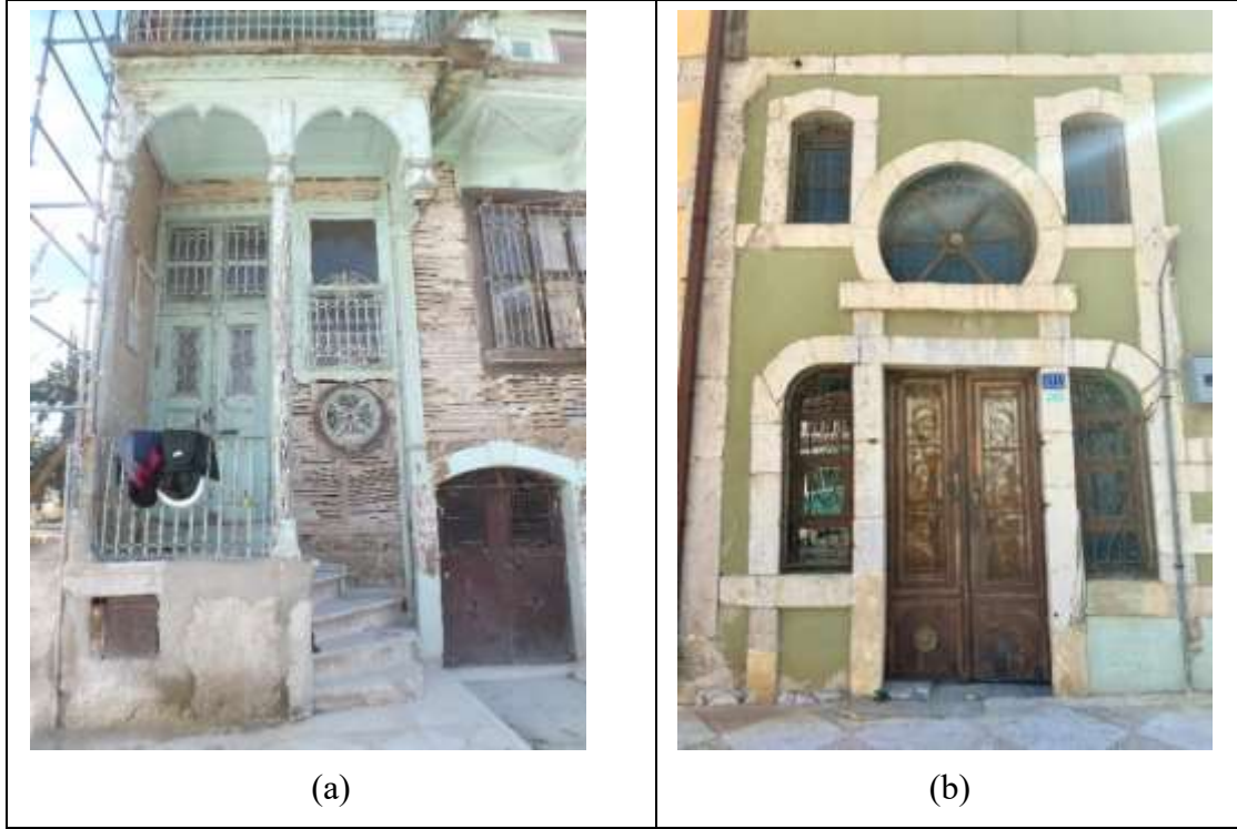
Resim 6.17. (a) Mustafa Demiray evi giriş kapısı ve barok penceresi ; (b) Musa Akgöl evi giriş düzenlemesi ve barok penceresi
