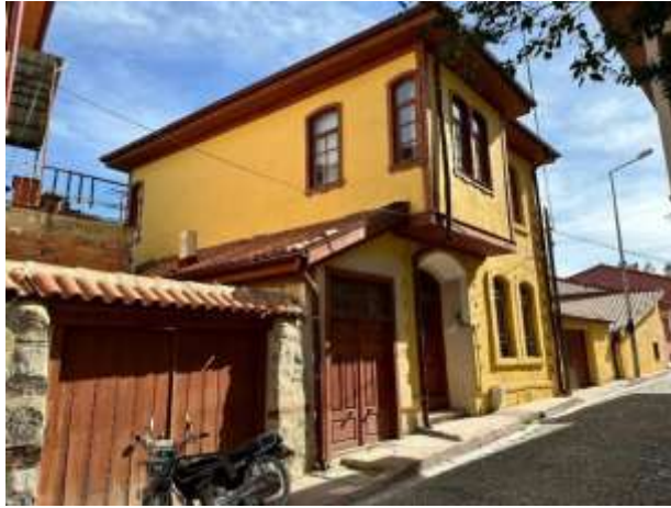
Resim 5.153. Hacı Hamza Sokak no:30 yan cephesi
