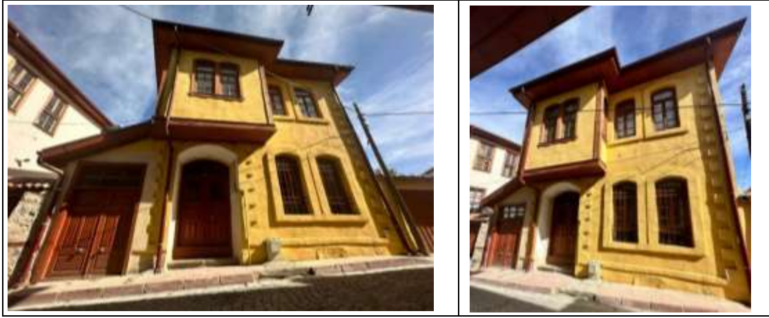
Resim 5.152. Hacı Hamza Sokak no:30 ön cephe fotoğrafları
