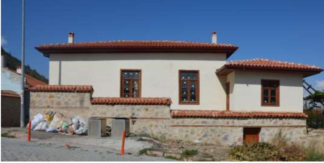
Resim 5.121. Hacı Hamza Sokak no:44 Şeker Sokağı bakan cephesi
