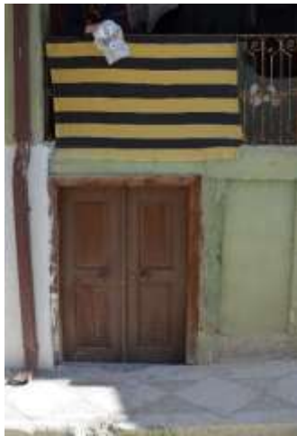
Resim 5.35. Alt Zemin kat depo giriş kapısı
