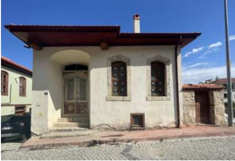
Resim 5.120. Hacı Hamza Sokak 44 numaralı yapı ön cephesi
