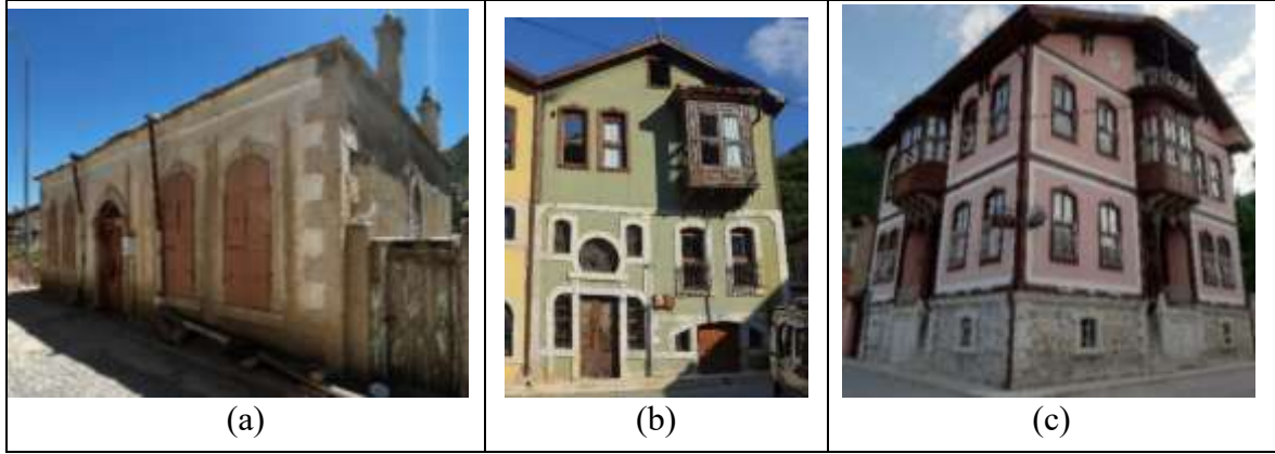
Resim 6.7. (a) Tuncer Öz evi girişi ; (b) Musa Akgöl evi girişi ; (c) Takkasızlar Konağı
