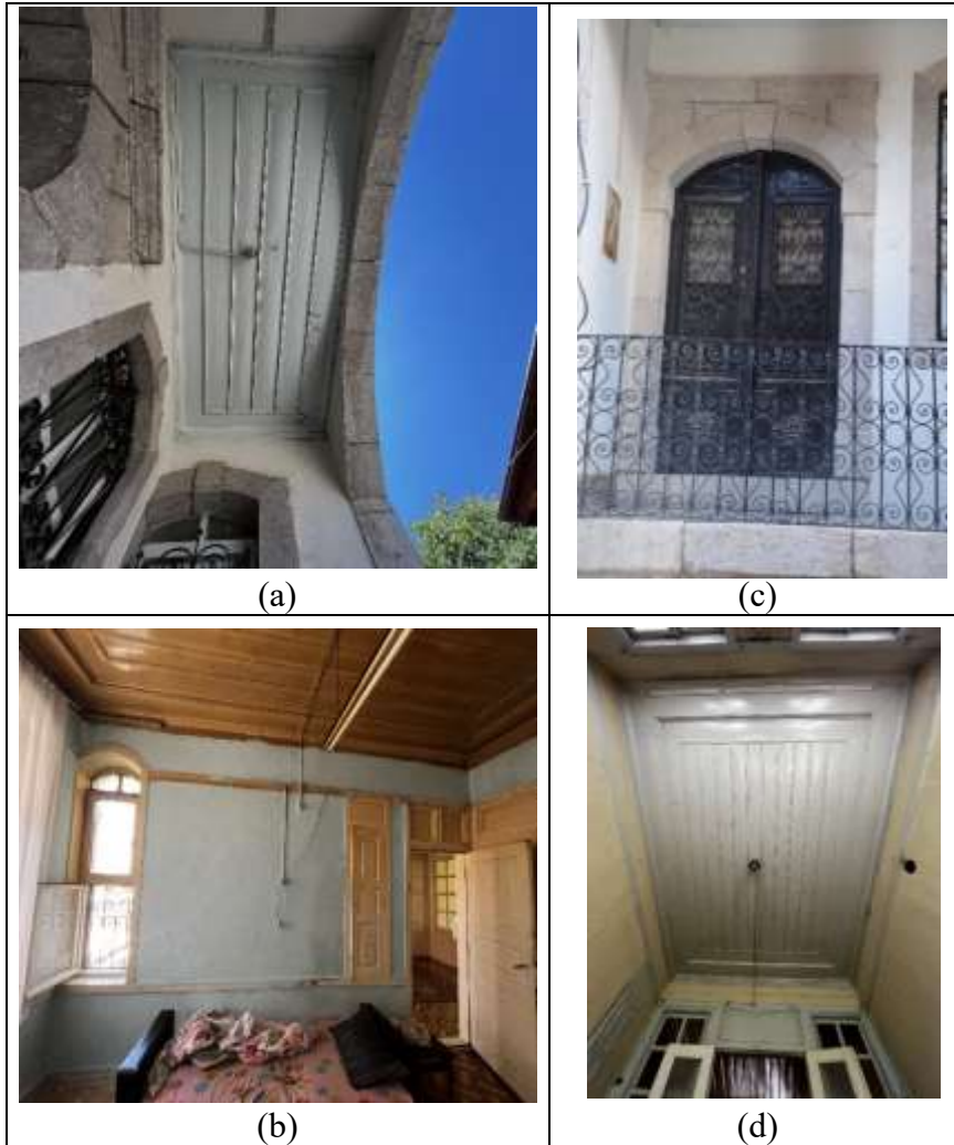
Resim 5.89. (a) Giriş sahanlığı tavan kaplaması (b) Giriş kapısı (c) Kim geldi penceresi, kat silmeleri ve ahşap gömme dolap (d) Ahşap tavan kaplama detayı
