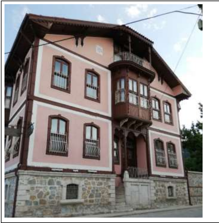
Resim 5.164. Takkasızlar Konağı kuzey cephesi
