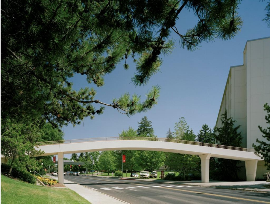
Resim 1.3. Düşey düzlemde eğri eksenli yaya köprüsü kirişleri
