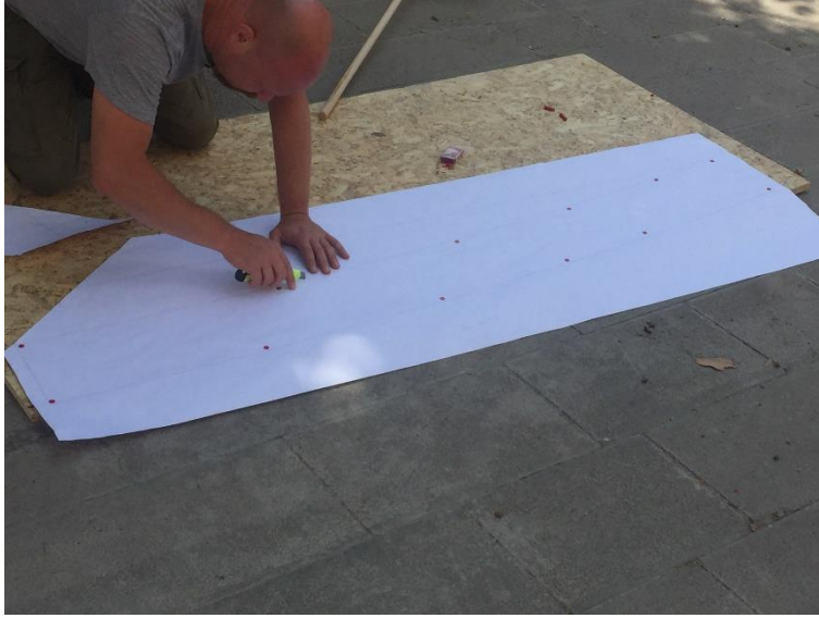
Resim 2.3. Eğri eksenli deney elemanlarının kalıplarının hazırlanışı
