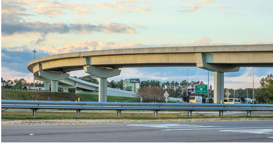
Resim 1.1. Yatay düzlemde eğri eksenli otoyol köprüsü kirişleri [1]
