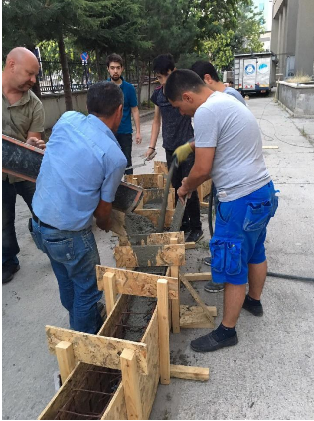
Resim 2.5. Beton dökümü ve vibratör ile sıkıştırma uygulaması
