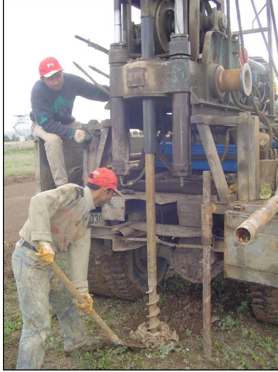
Resim 3.3. Sondaj çalışması (SK-1 kuyusu)
