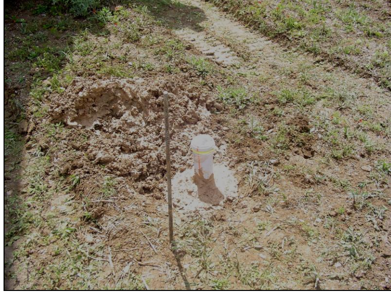
Resim 3.6. Sondaj işlemi sonrası muhafazaya alınan sondaj kuyusu
