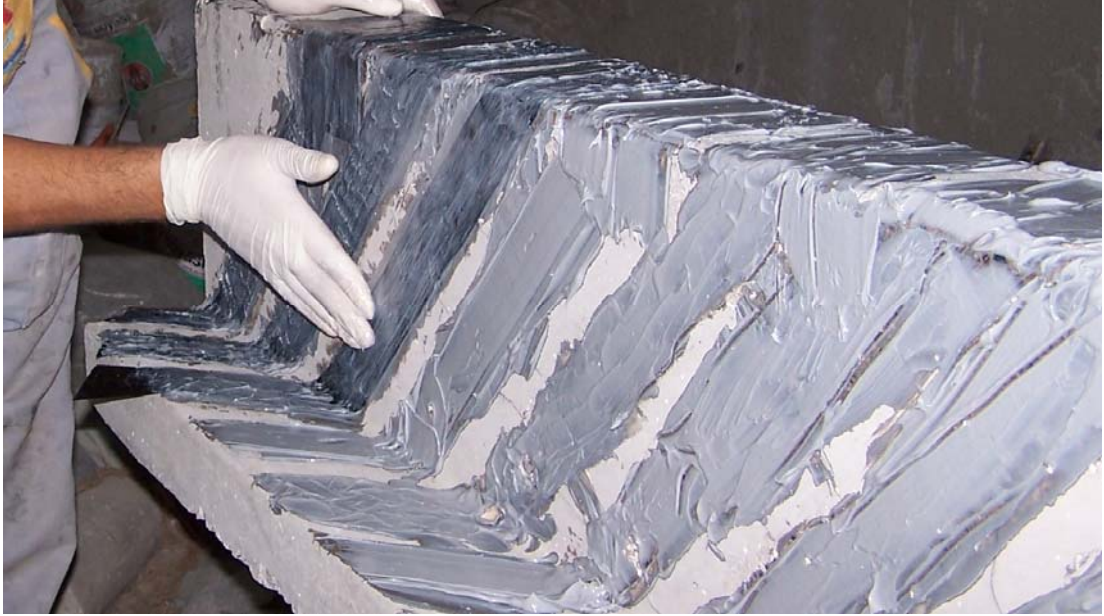
Resim 2.3. CFRP şeritlerin kirişe yapıştırılması
