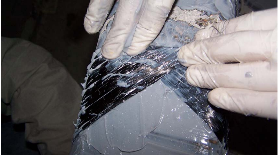
Resim 2.4. CFRP şeridin kiriş altında doğrultu değiştirmesi
