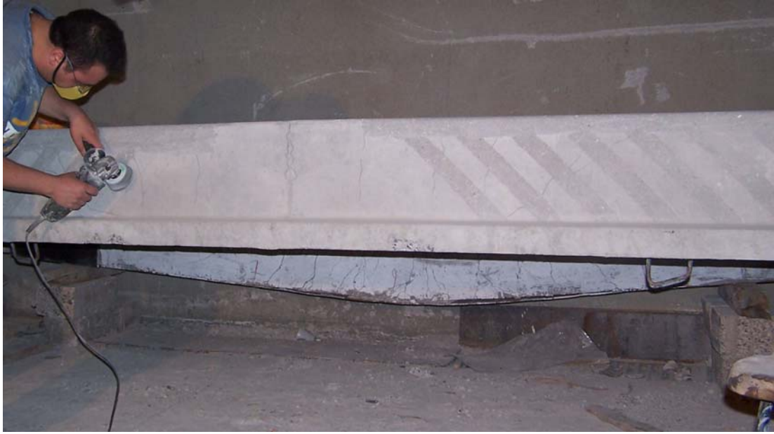
Resim 2.2. Kiriş yüzeyinin hazırlanması
