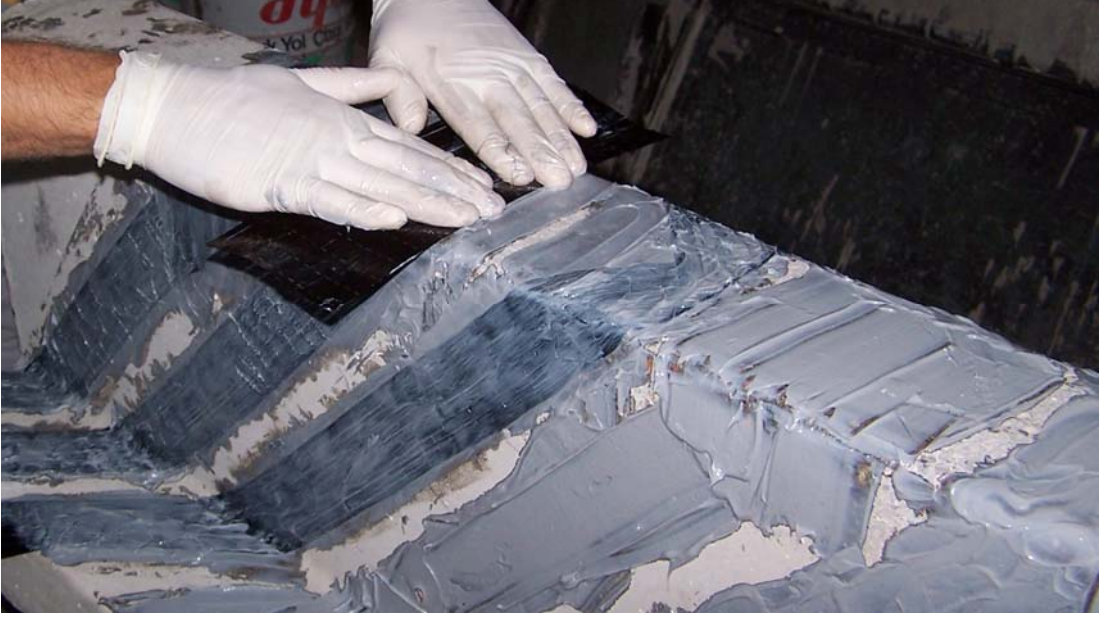
Resim 2.5. 100 x 250 mm'lik CFRP parçaların kiriş altına yapıştırılması
