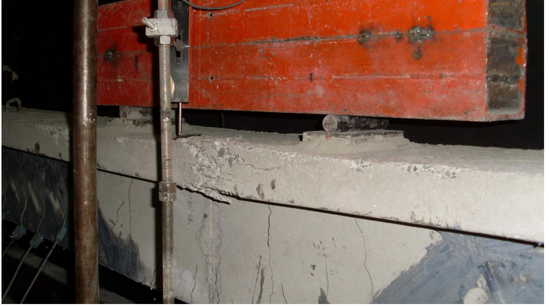
Resim 4.19. Beton basınç bölgesinin ezilmesi, deney elemanı 6
