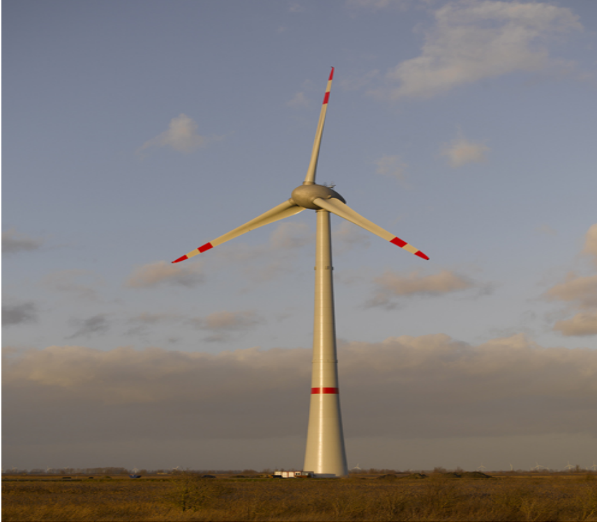
Resim 2.2. Rüzgâr türbini (7,58 MW)
