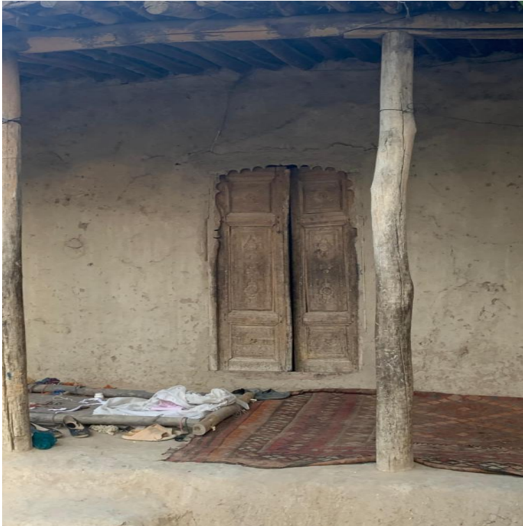
Resim 4.32. İkinci ev Ahşap kapısı
