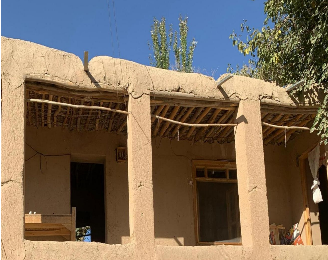
Resim 4.29. Meymene kentindeki kerpiç evlerde yağmur suyu toplama sistemi (çörten)
