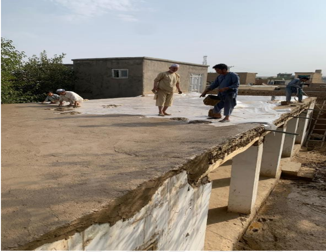
Resim 4.27. Çatıda ısı yalıtımı için plastik bir tabaka kullanılması ve yıl boyunca nem yalıtımı için plastiğin üstünde saman kullanılması
