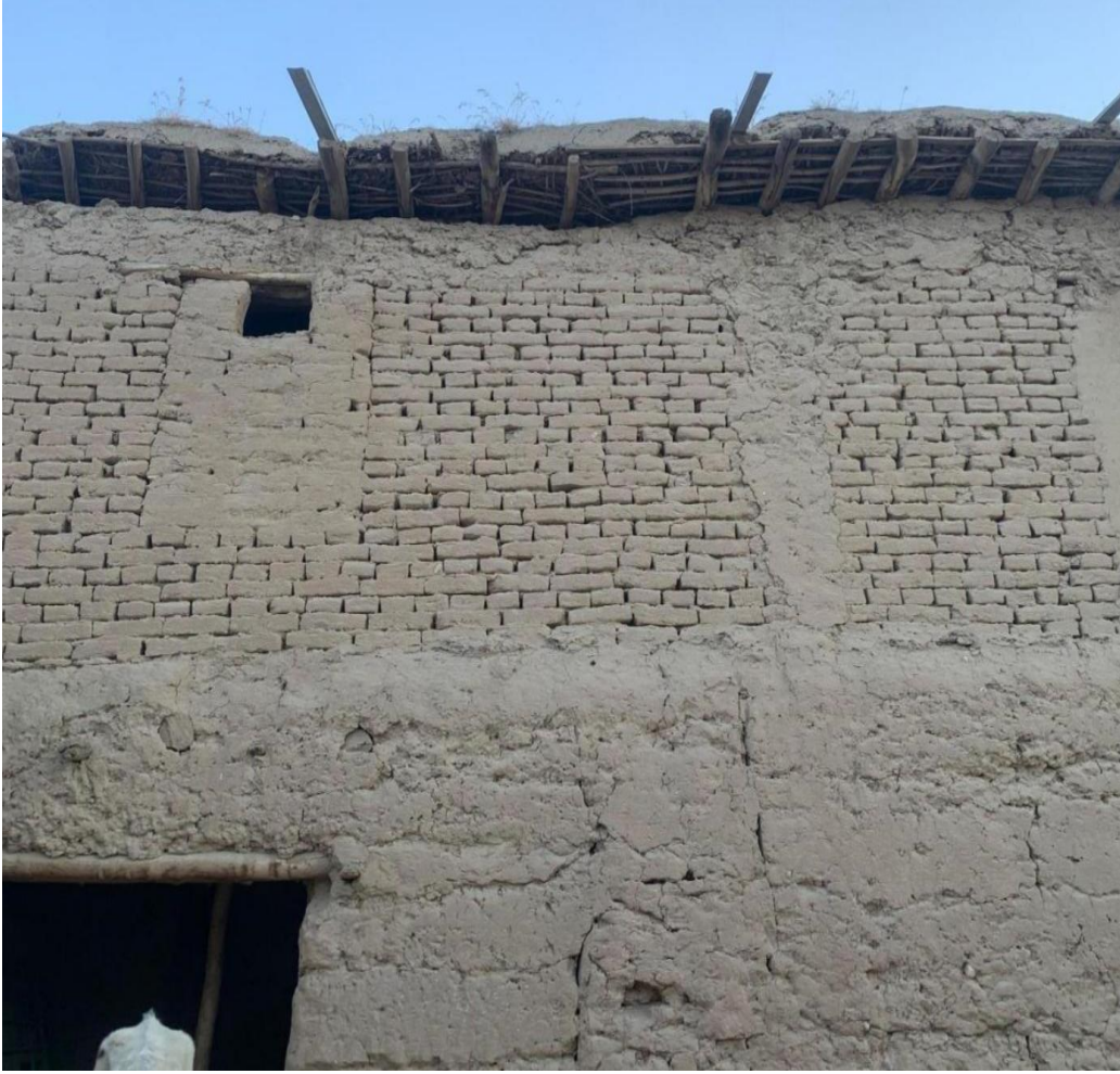
Resim 4.10. Meymene şehrinde ham tuğla duvar
