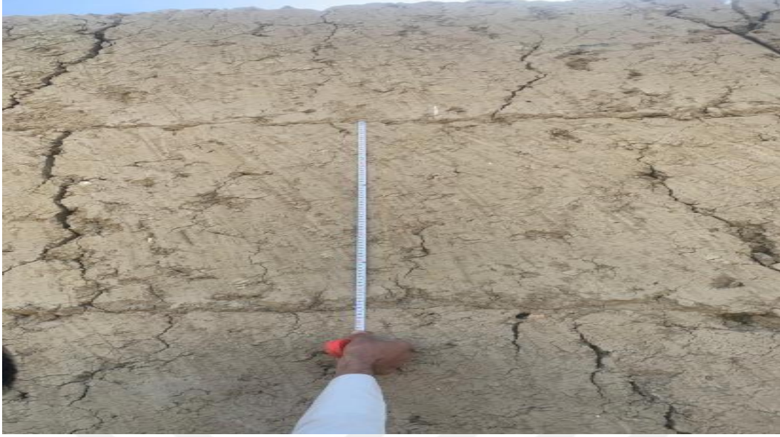
Resim 4.15. Kerpiç duvar ve onunla doğrudan temas halinde olan dikey mesafe, toprağın yapışkanlığına bağlı olarak 50 cm ila 100 cm arasında değişir
