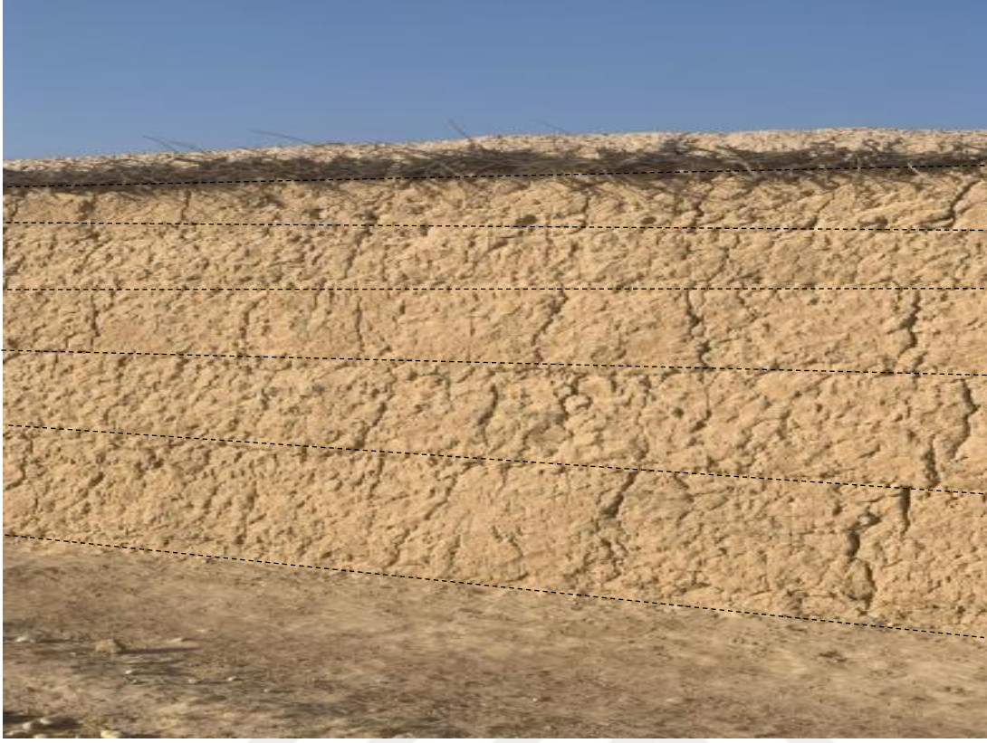
Resim 4.9. Meymene şehrinde kerpiç duvar
