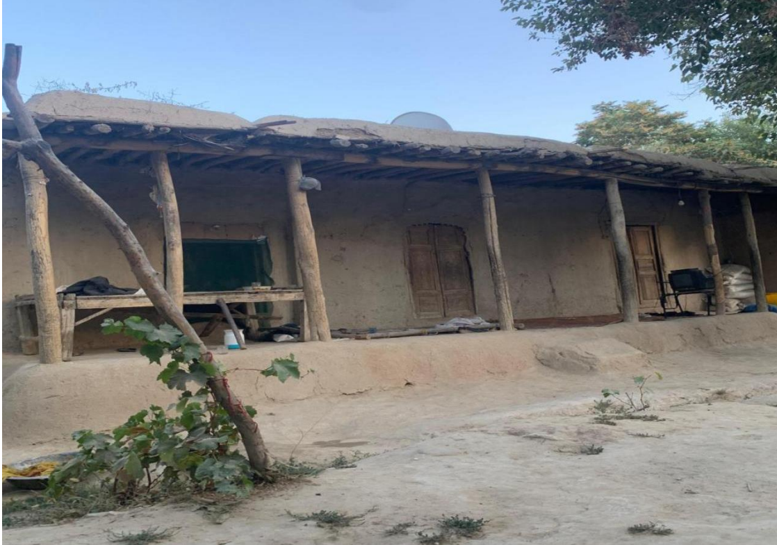
Resim 6.12. İkinci Ev iç avlusundan genel görünümü
