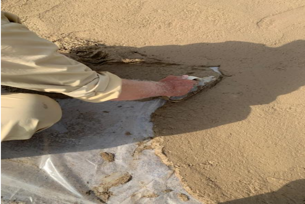
Resim 4.28. Çatıda sıva malası ile saçak düzeltme işlemi genellikle 2,5 cm ile 5 cm arasında bir kalınlıkta yapılır
