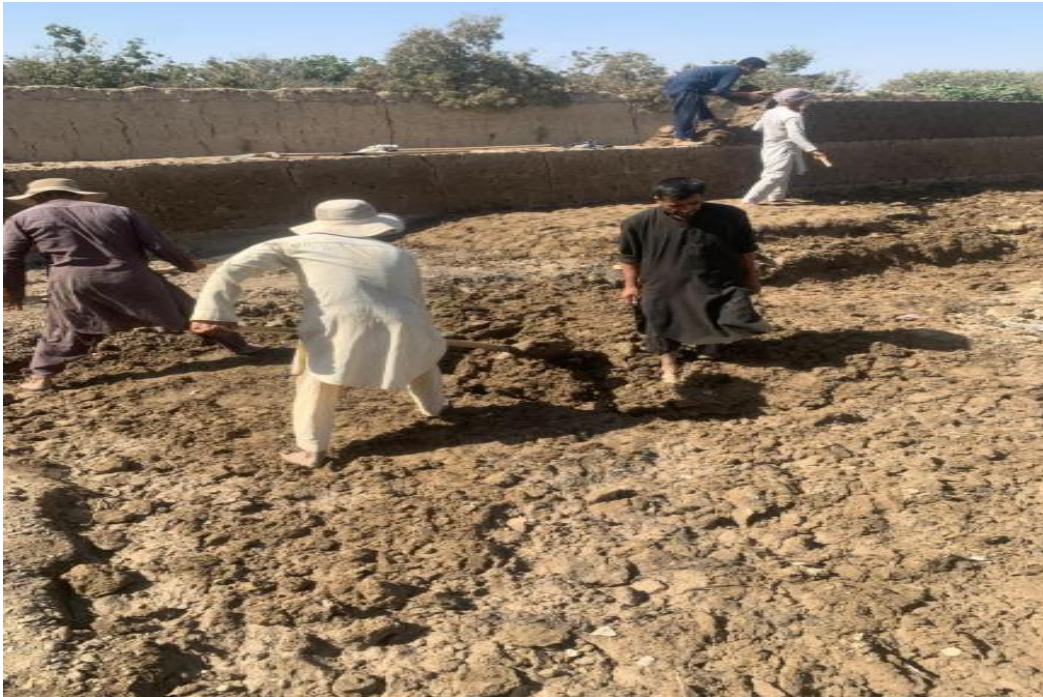
Resim 4.12. Elde edilen kerpiç karışımının duvar yapımı için hazırlanması
