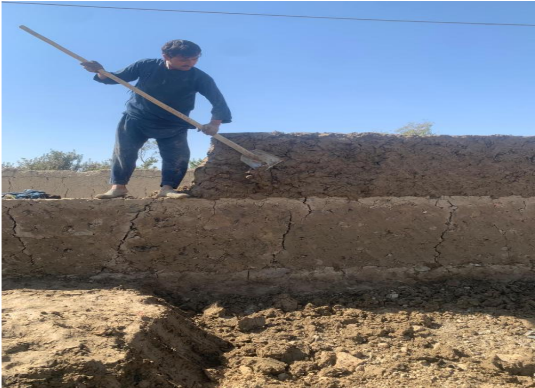
Resim 4.14. Kürek veya (beil) adı verilen teknik bir aletle bir kerpiç duvarın düzleştirilmesi
