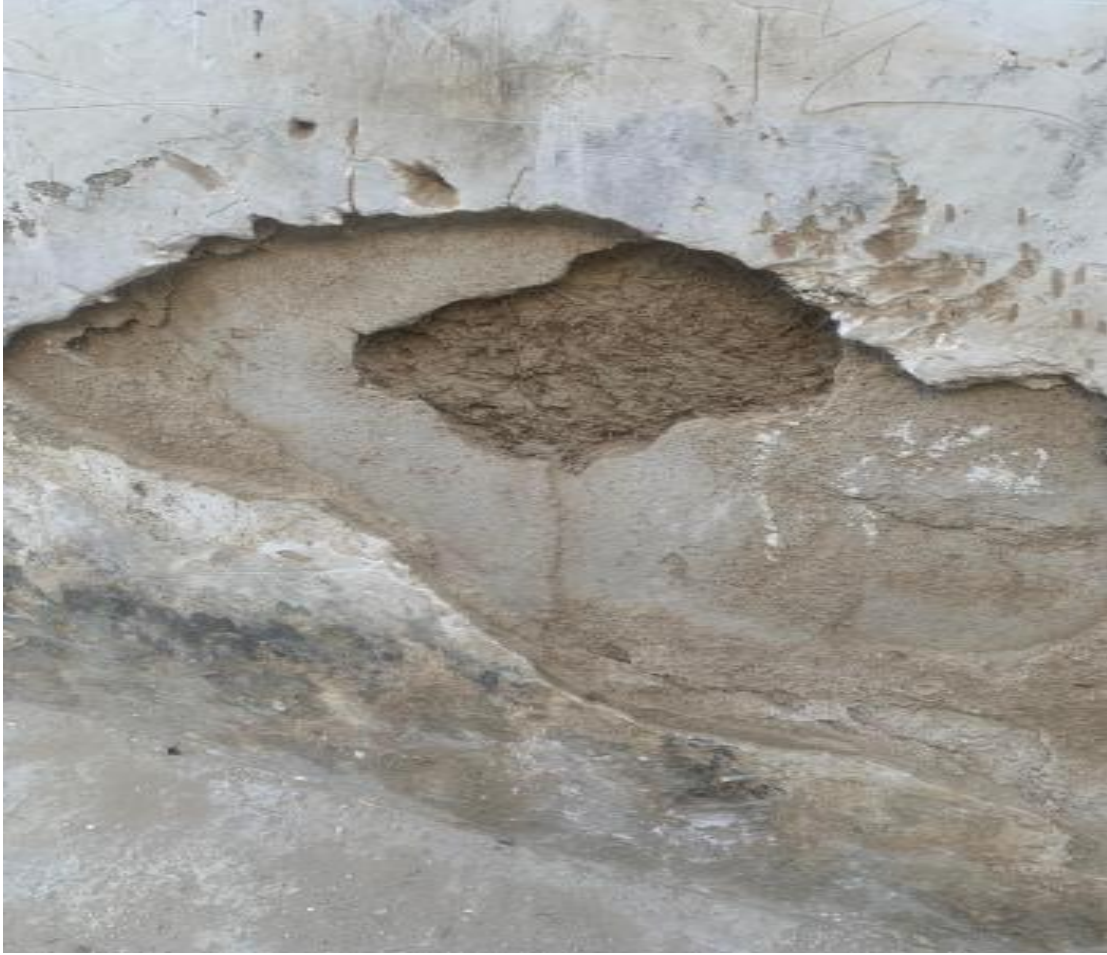
Resim.4.20. Meymene kentinde yıllar içinde çeşitli kaplamalarla kaplanmış bir kerpiç evin cephe detayı
