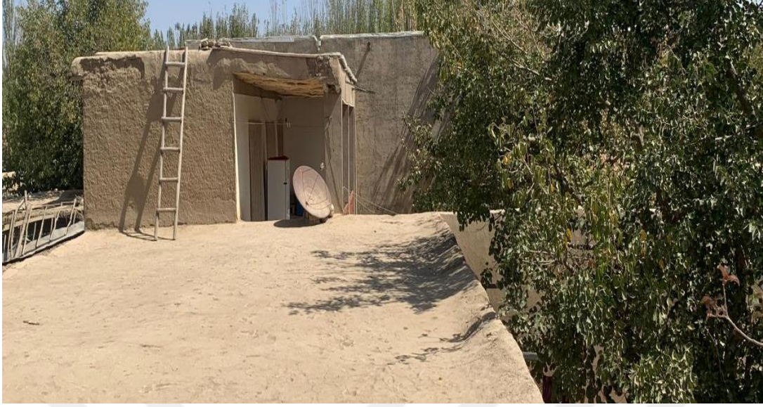
Resim 4.24. Meymene kentindeki kerpiç konutlarda düz çatılar
