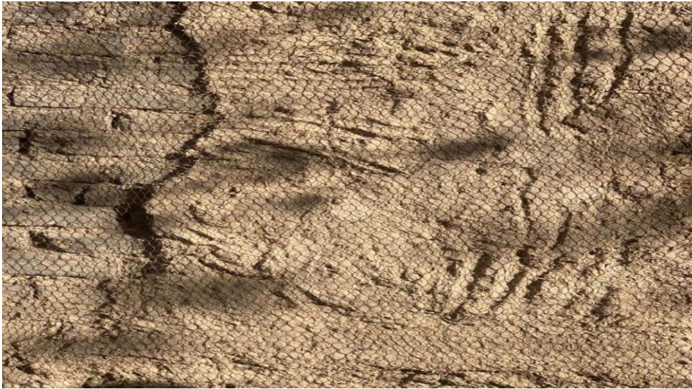
Resim 4.22. Kerpiç evin tüm cephesinin kerpiç cephe üzerine çimento yapıştırılması için metal ağ ile kaplanması
