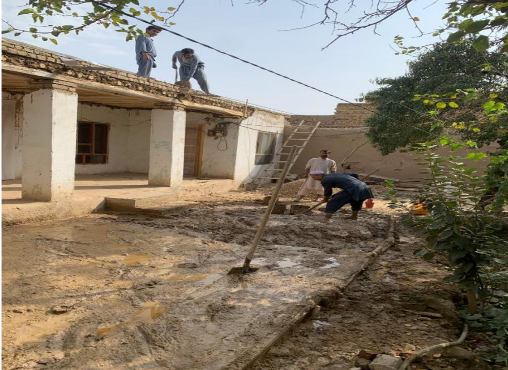
Resim 4.26. İki gün bekletildikten sonra bu iki gün boyunca karıştırılarak Kahgil hazırlanır
