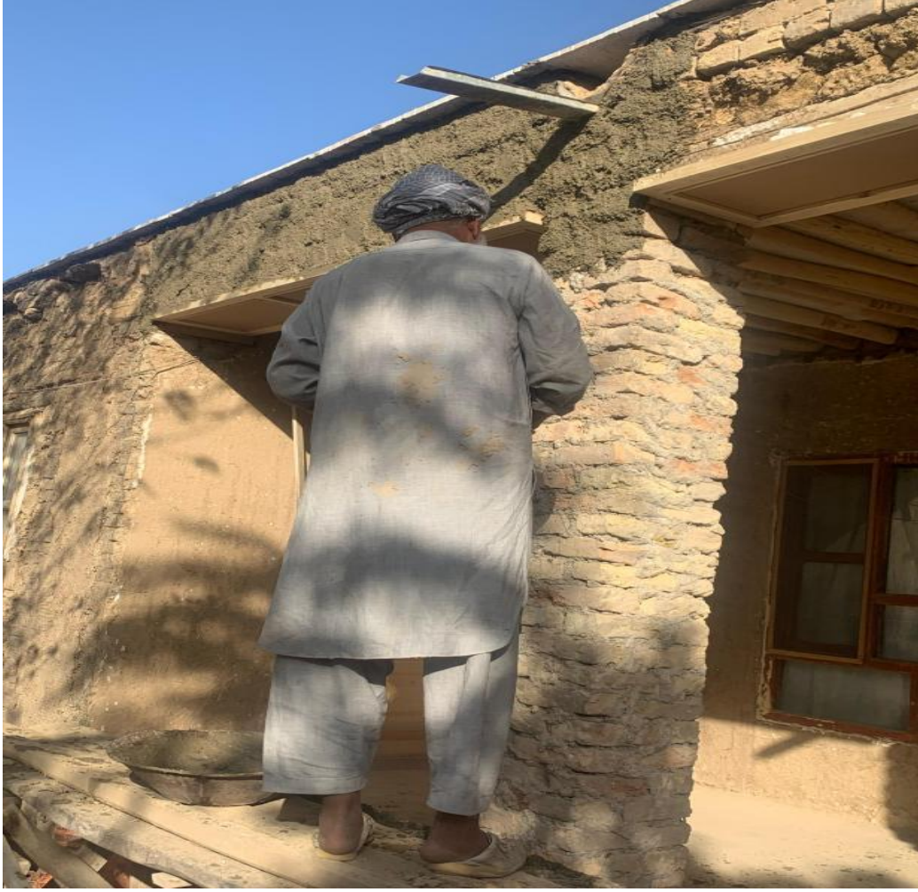
Resim 4.23. Tuğla cephenin işçi tarafından çimentolanması aşaması
