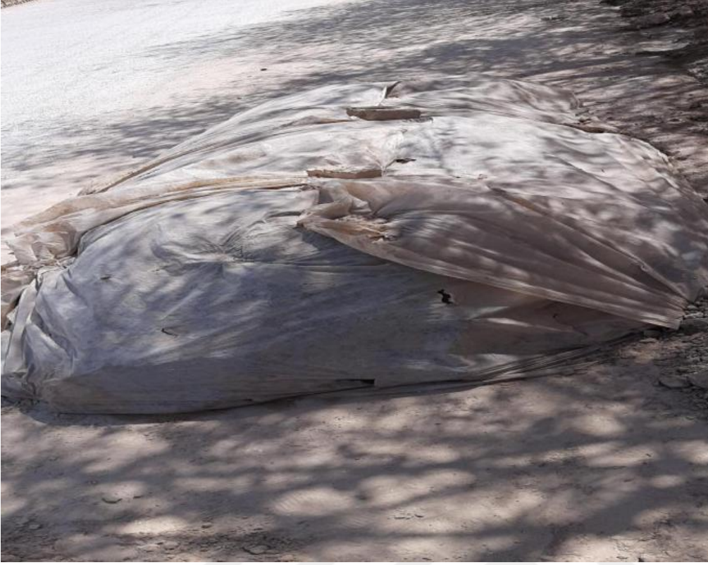
Resim 4.17. Toprak hazırlama aşaması ve toprağın yapışması için 2 ila 3 gün bekletilmesi
