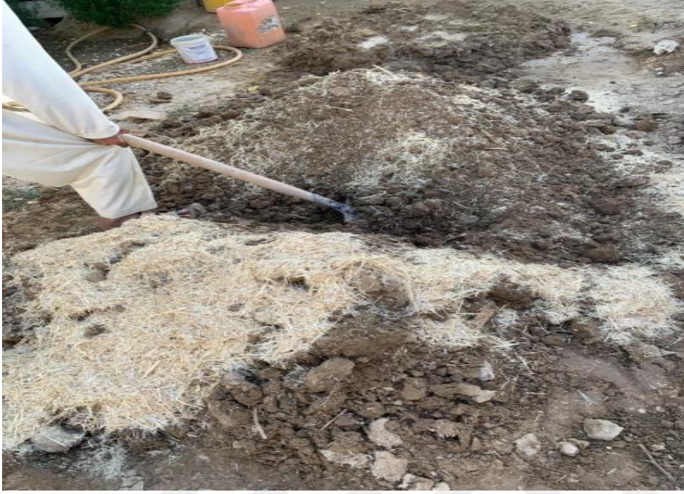
Resim 4.25. Kahgil hazırlamak için toprağın saman ve su ile karıştırılması aşaması
