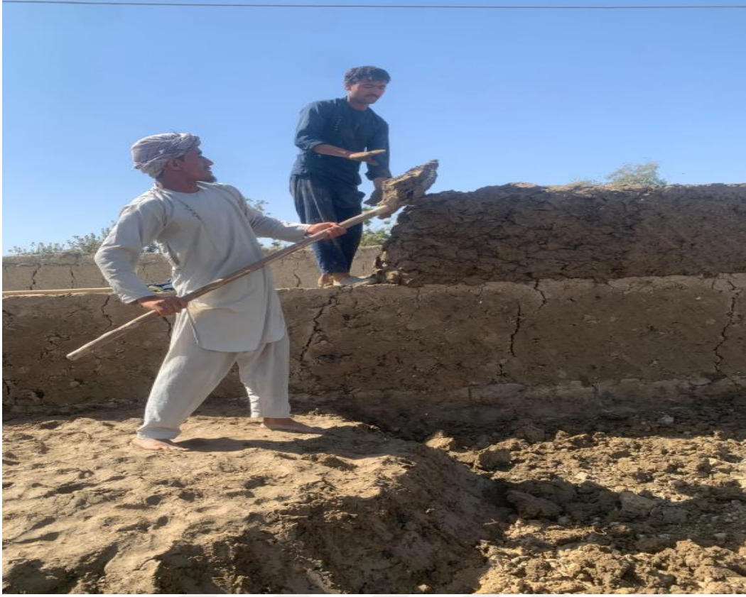
Resim 4.13. Duvar inşa etmek için hazırlanmış kerpiçi kullanma
