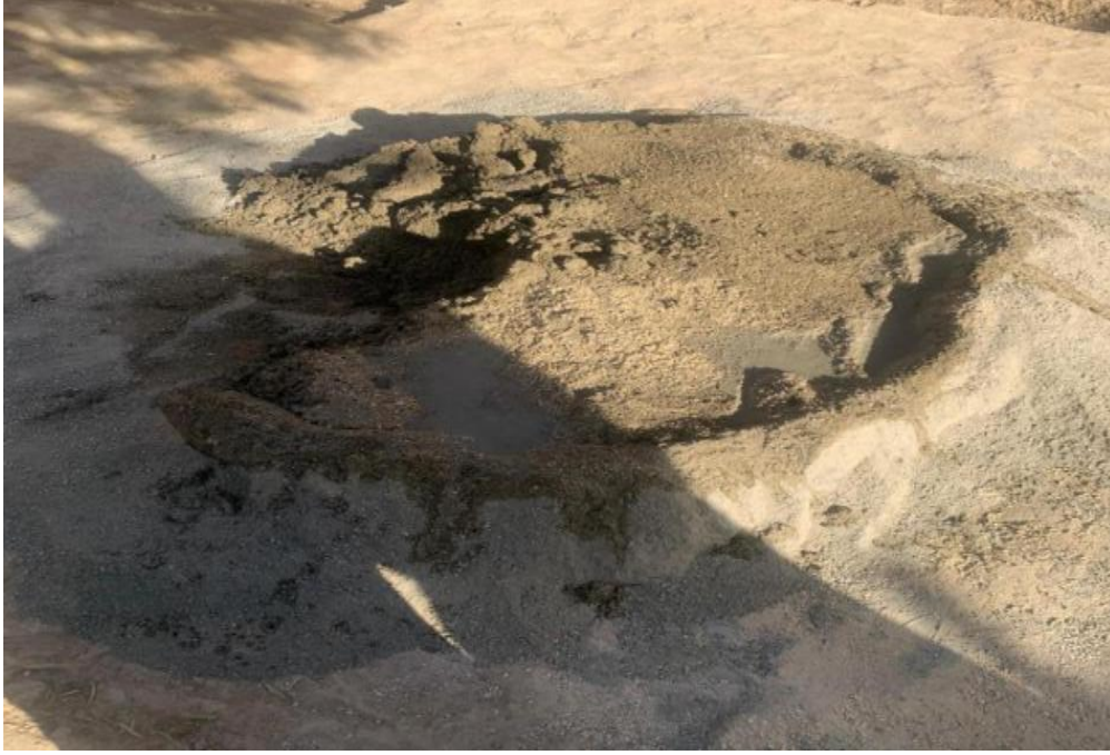
Resim 4.21. Kerpiç bir binanın dış cephesini kaplamak için kum ve çimento karışımı
