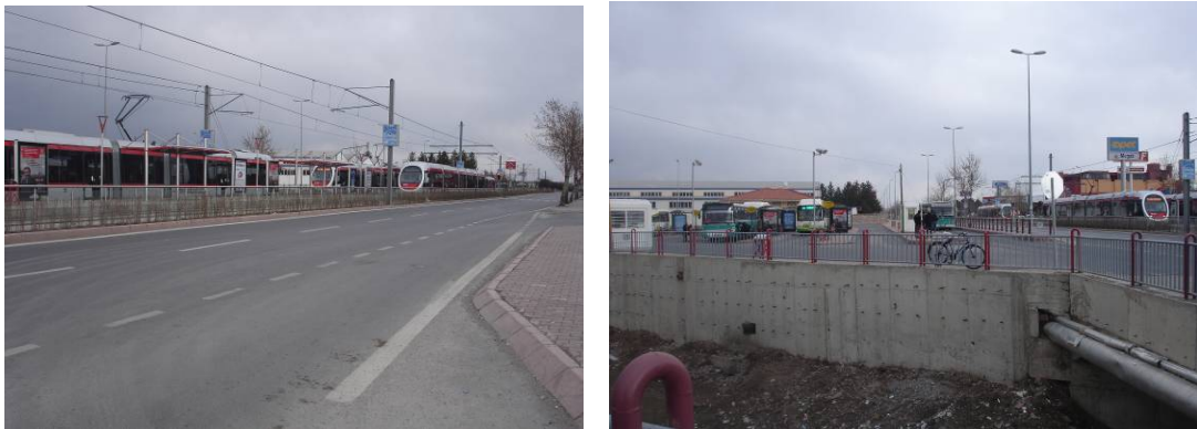
Resim 5.5. Son durak (doğu terminali) depolama ve otobüs aktarma noktası
