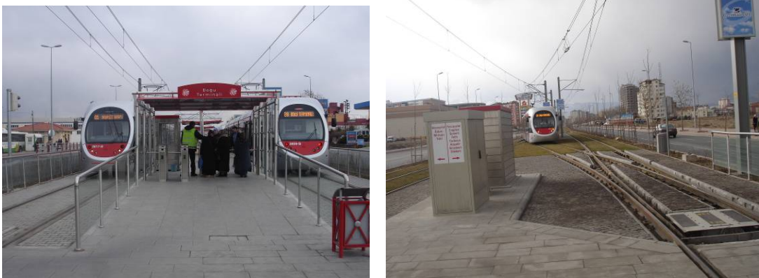
Resim 5.4. Son durak (doğu terminali) ve makas sistemi
