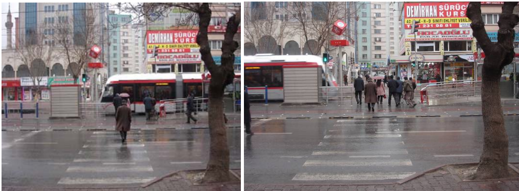
Resim 5.8. Kayseray durağında (Hunat) raylı sistem öncelikli-kontrolsüz yaya geçidi
