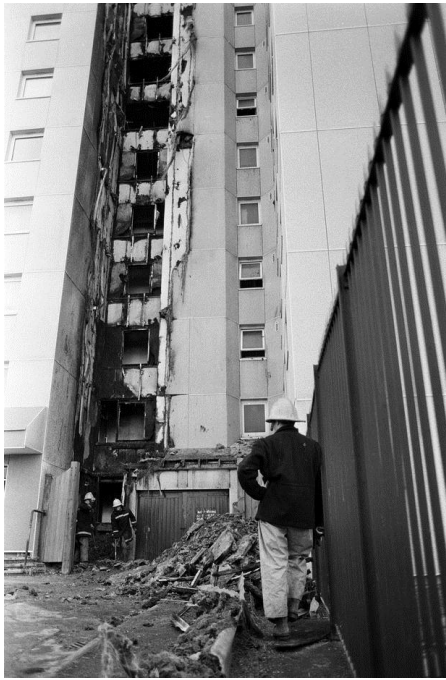
Resim 3.4. Cephe geometrisi ve yangının yayılması [110]
