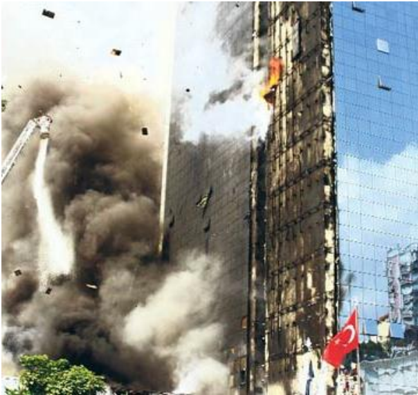
Resim 3.2. Cephe yangını sırasında dağılan parçalar [94]
