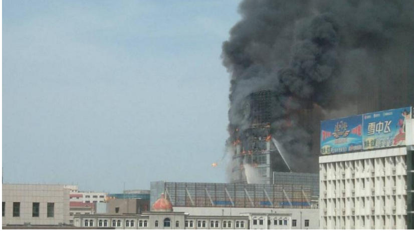
Resim 2.2. Çift katmanlı cephelerde yangın ve yanarak dağılan parçalar [56]
