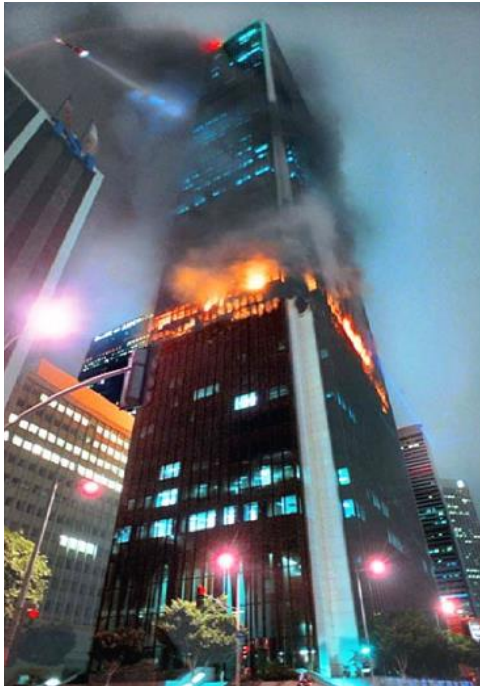
Resim 2.4. Cam giydirme cephede yangın oluşması ve yayılması [65]
