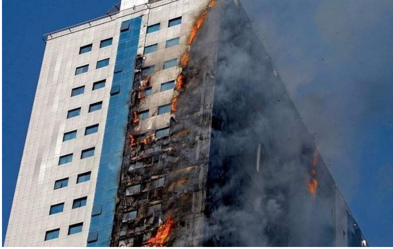
Resim 3.3. Bina açıklıklardan yangının yayılması [102]
