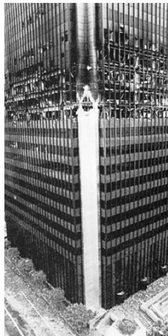
Resim 2.4. Cam giydirme cephede yangın oluşması ve yayılması [65]
