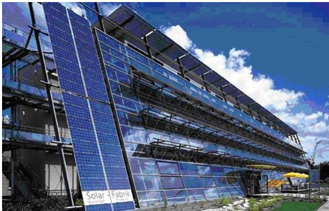
Resim 2.9. Solar Fabrik binasında fotovoltaik panel kullanımı [79]
