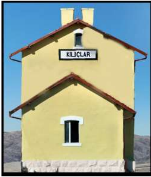
Resim 3.22. Güney cephe fotoğrafı
