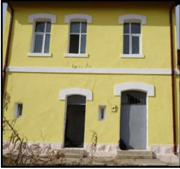
Resim 4.13. Zemin katta açılan pencereler (P4pvc 40/75)
