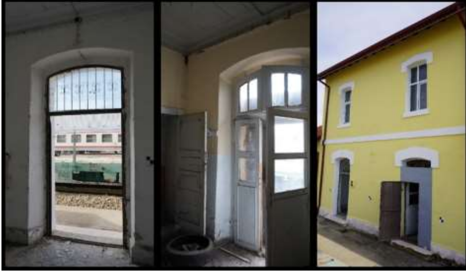
Resim 4.18. Z07 Demir doğrama, Z06 K5 ahşap kapı, Z06 DK1 demir doğrama
