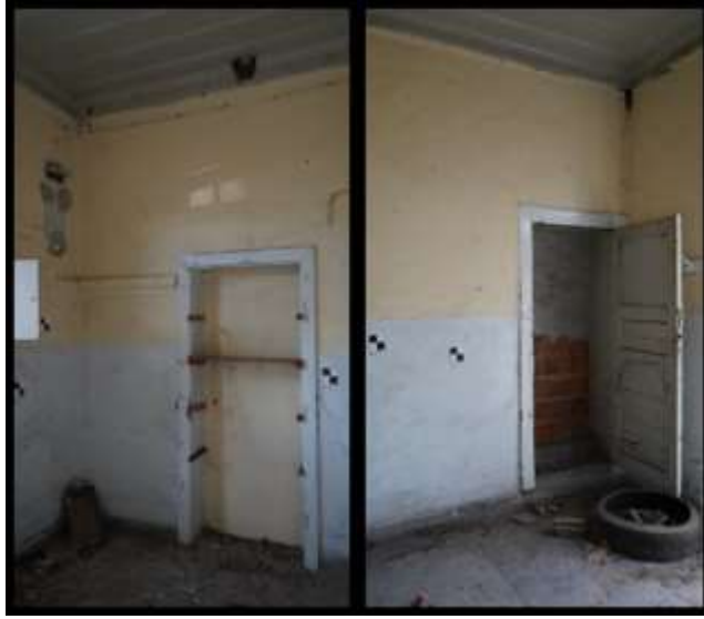
Resim 4.17. Zemin katta kapatılan kapı boşlukları (sağdaki Z-05- Z-06 arası, soldaki Z-06, Z-07 arasında)
