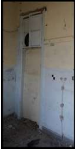
Resim 3.74. İç kapı fotoğrafı iki
