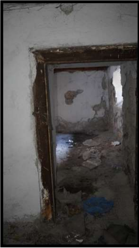
Resim 3.31. B-03 mahalli batı cephe fotoğrafı
