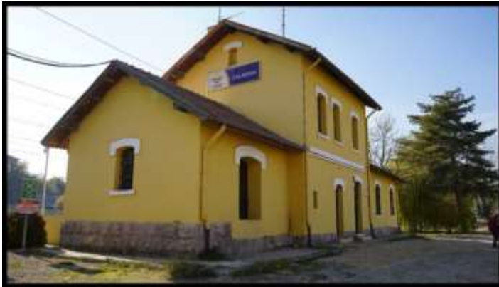
Resim 4.10. Lalahan istasyon binası
