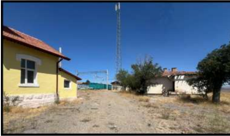
Resim 3.7. İstasyon binası yakın çevre yapıları
