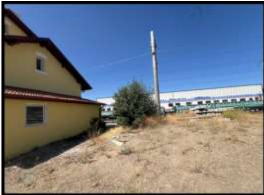
Resim 3.4. İstasyon binası ve bakım tesisi
