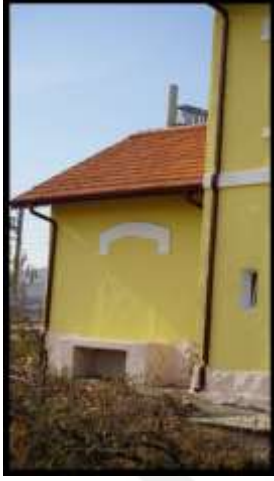
Resim 4.15. Zemin katta kapatılan kapı boşluğu (Ambar K2)
