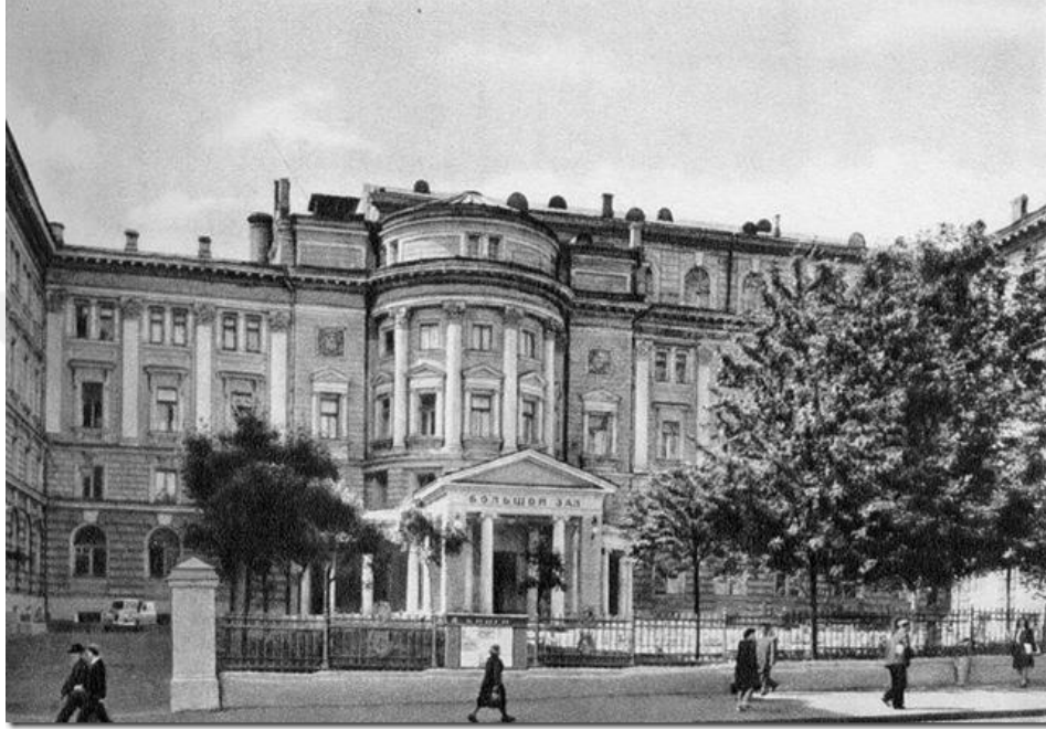
Şekil 4. Moskova P.İ.Tchaikovsky Devlet Konservatuarı binası
