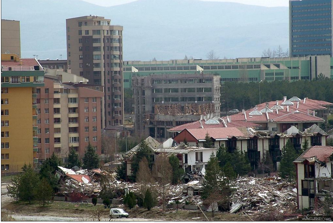
Şekil 5.13. Milletvekili lojmanlarının yıkılım sürecindeki bir görüntü (Galpay, 2007)
