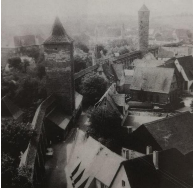
Resim 4.2. Rothenburg'u çevreleyen kent duvarı (Zeidler, 1985: 11)
