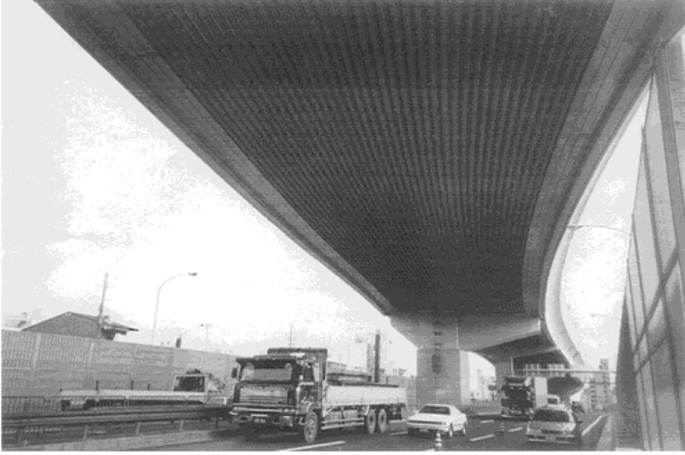
Resim 4.6. Metalik köpüklerin ses yalıtımı olarak viyadükte kullanımı [34]
