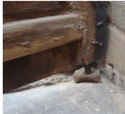
Resim 4.5. Zemin ile ilişkilendirilmiş açılıp kapanma sistemi görüntüleri (alt)
