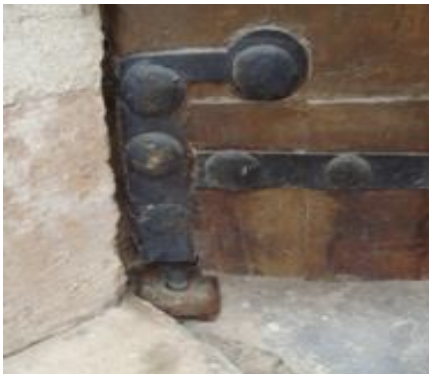
Resim 4.5. Zemin ile ilişkilendirilmiş açılıp kapanma sistemi görüntüleri (alt)
