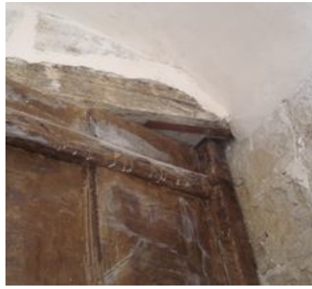
Resim 4.4. Lento ile ilişkilendirilmiş açılıp kapanma sistemi görüntüleri (üst)
