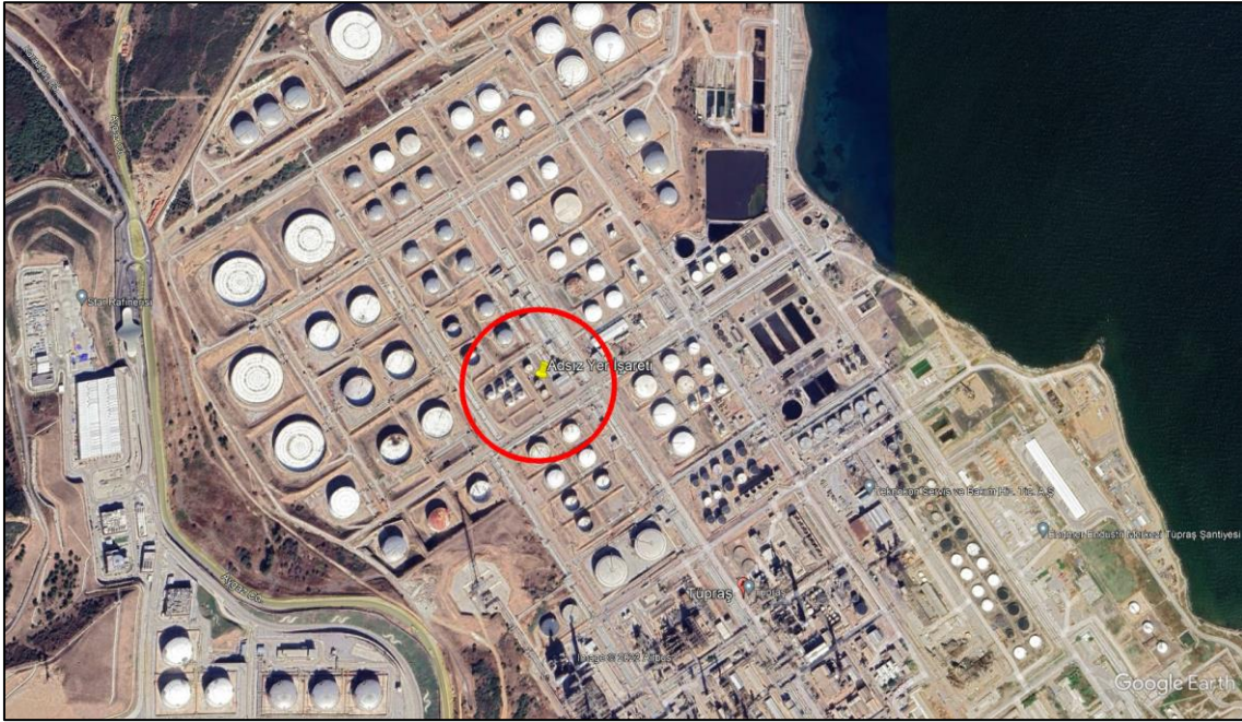
Resim 5.1. Örnek kuruluştaki 3152 nolu Benzin Tankında Yangın Etki Alanı Google Earth görüntüsü
