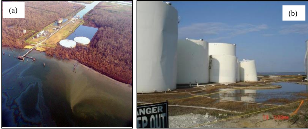
Şekil 4.2. Sel sırasında tankın yer değiştirmesi (a)ve burkulma (b) örneği (e-NATECH)
