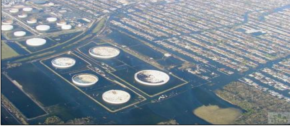
Resim 2.2. Japonya’da tsunami etkisiyle sular altında kalmış tank çiftliği görüntüsü (Loss Prevention, 2021)
