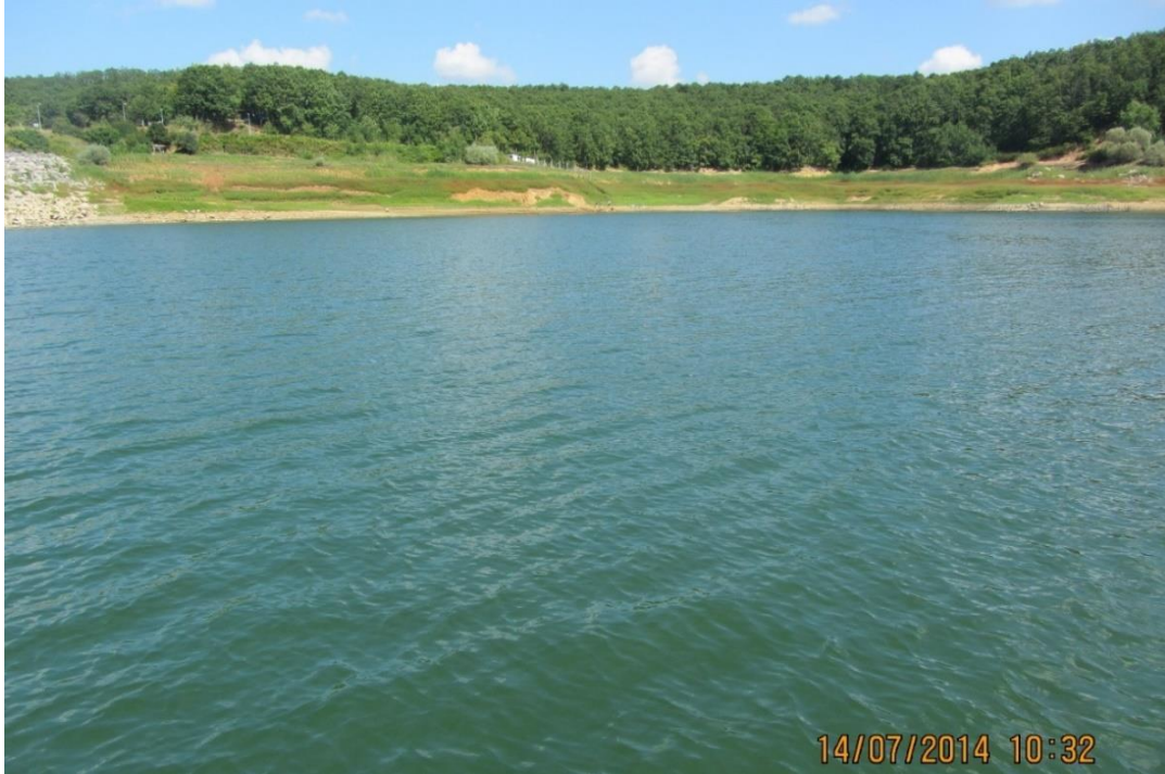
Resim 2.8. Ömerli Barajı (11 nolu istasyon)
