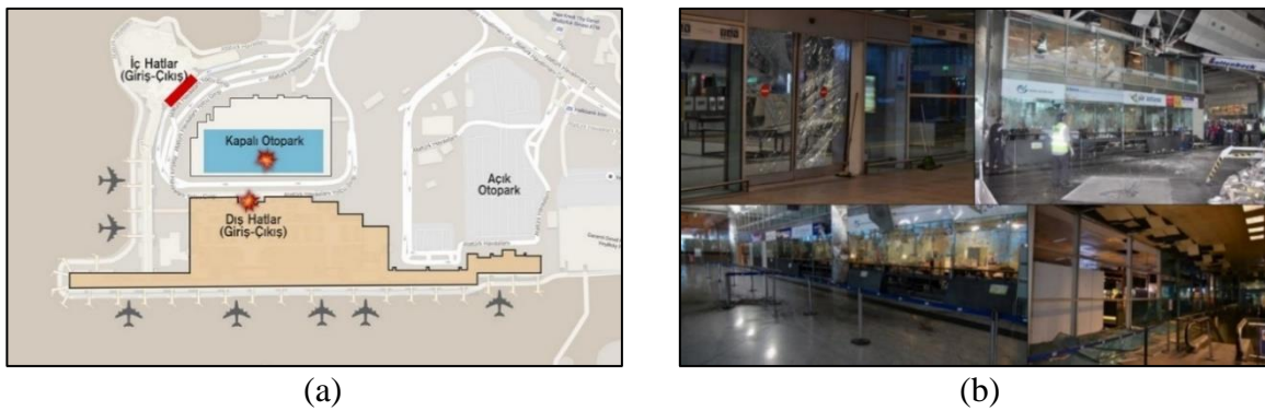
Şekil 1.1. İstanbul Atatürk Havalimanı saldırısı ve saldırı sonrası yapısal olmayan hasarlar (URL-5,6)
