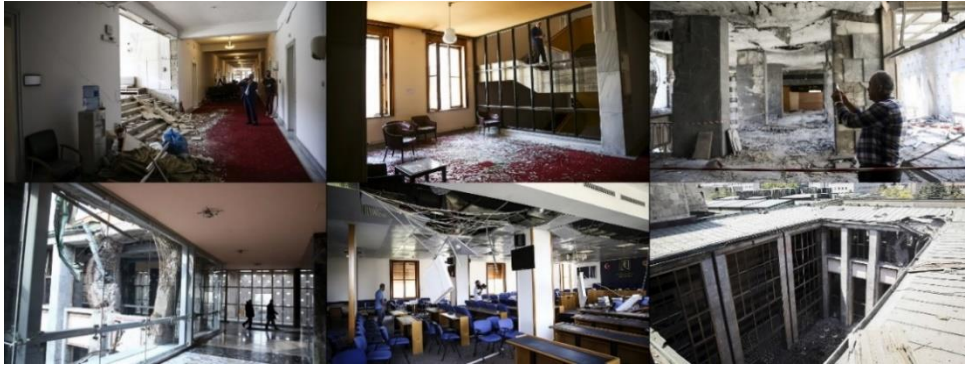
Resim 3.2. 15 Temmuz TBMM saldırısı yapı hasarı (URL-1)
