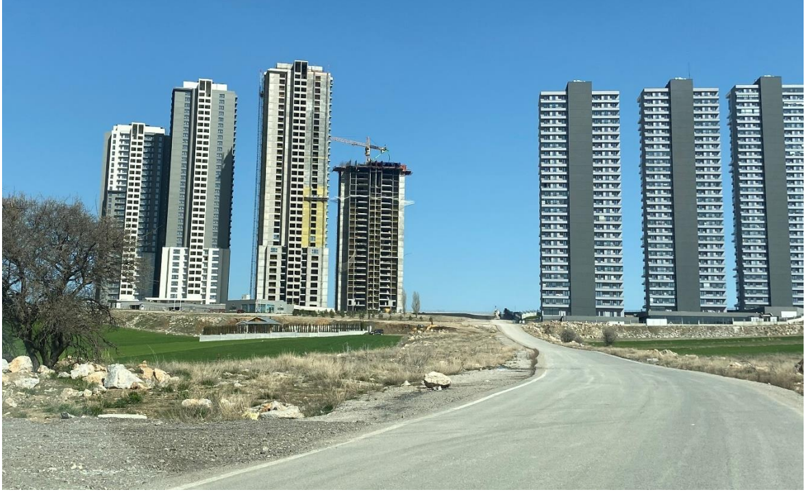
Resim 5.46. İncek Mahallesiindeki mevcut yollardan bir görünüm
