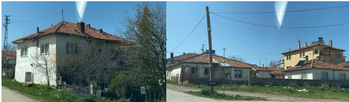
Resim 5.7. İncek Mahallesi eski köy yerleşiminden bir görünüm
