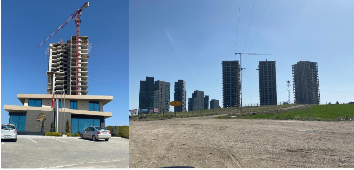
Resim 5.1. İncek Mahallesi'nde inşaatı devam eden lüks konut projeleri
