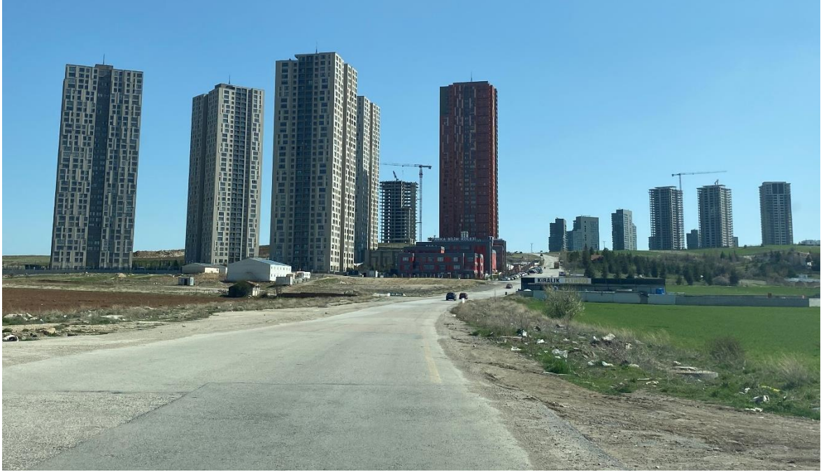
Resim 5.47. İncek Mahallesiindeki mevcut yollardan bir görünüm
