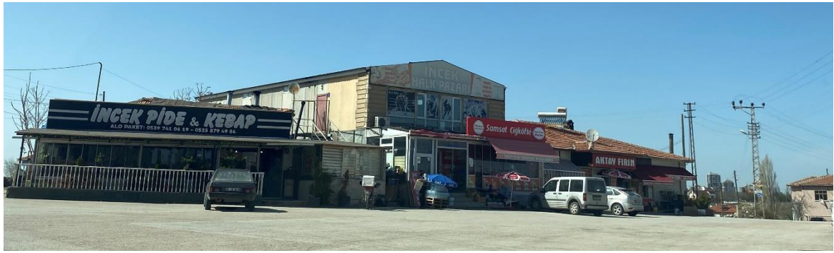
Resim 5.2. İncek Mahallesi eski köy yerleşiminden bir görünüm
