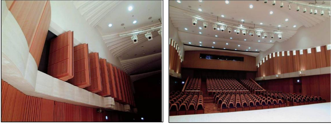
Resim 2.9. Toppan Oditoryumu hareketli duvar panelleri ve salon genel görünümü (Türkmen, 2013)
