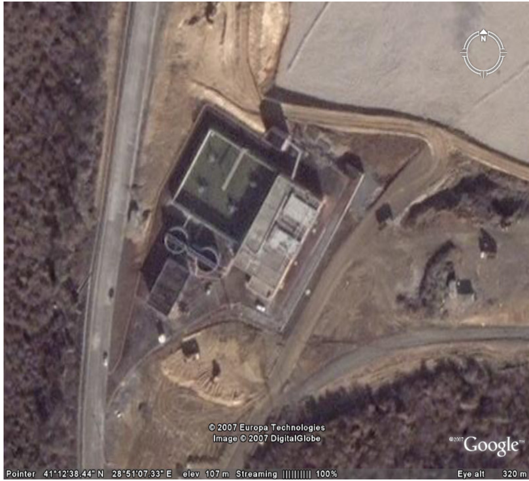
Resim 6.2.Odayeri sızıntı suyu arıtma tesisi genel görüntüsü
