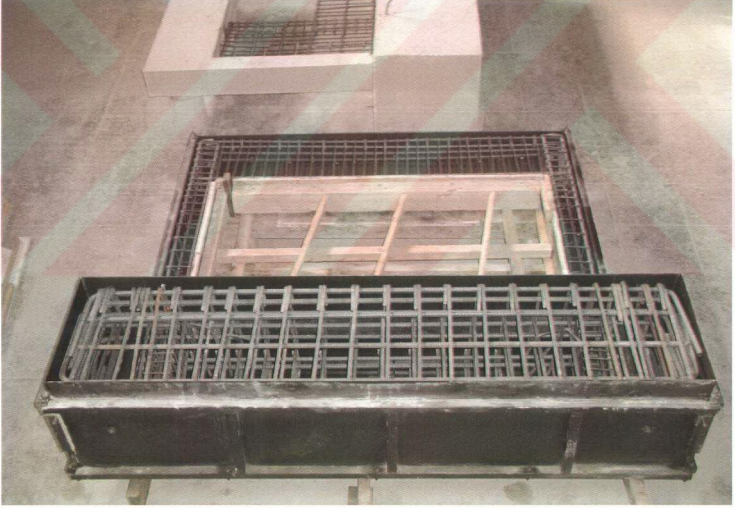
Şekil 4.10. Kalıp içine yerleştirilmiş çerçeve donatısı
