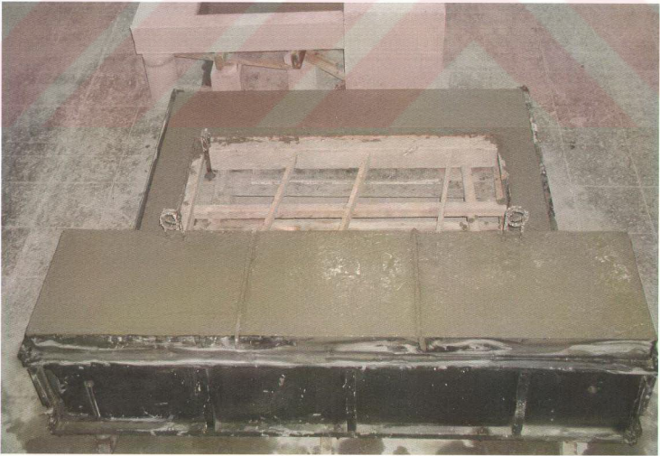
řekil 4.11. Beton dkm tamamlanmıř ereve
