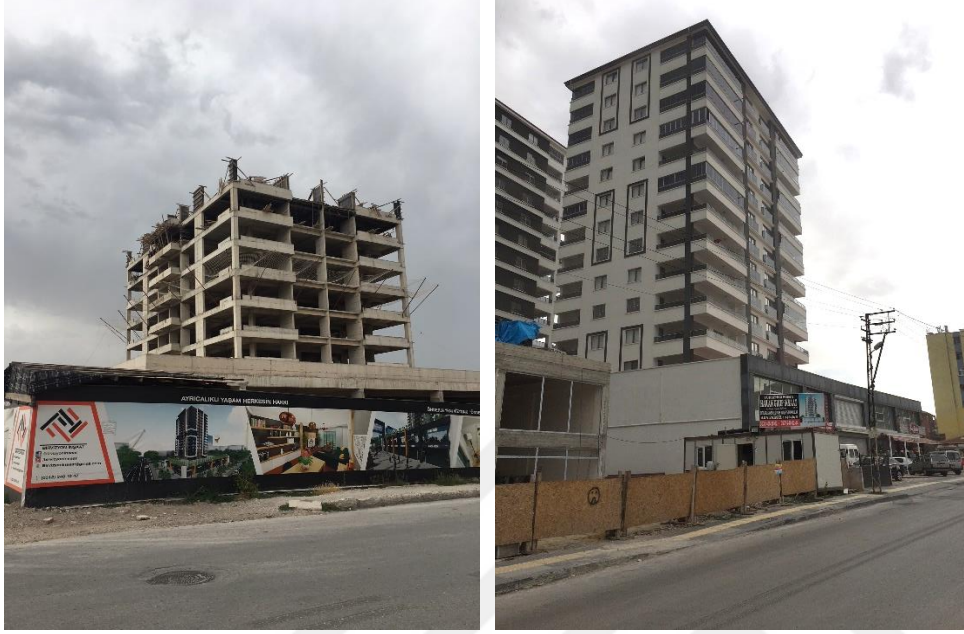
Resim 3.7. Yıkım alanında başlayan inşaatlar (yazar arşivi, 2018)
