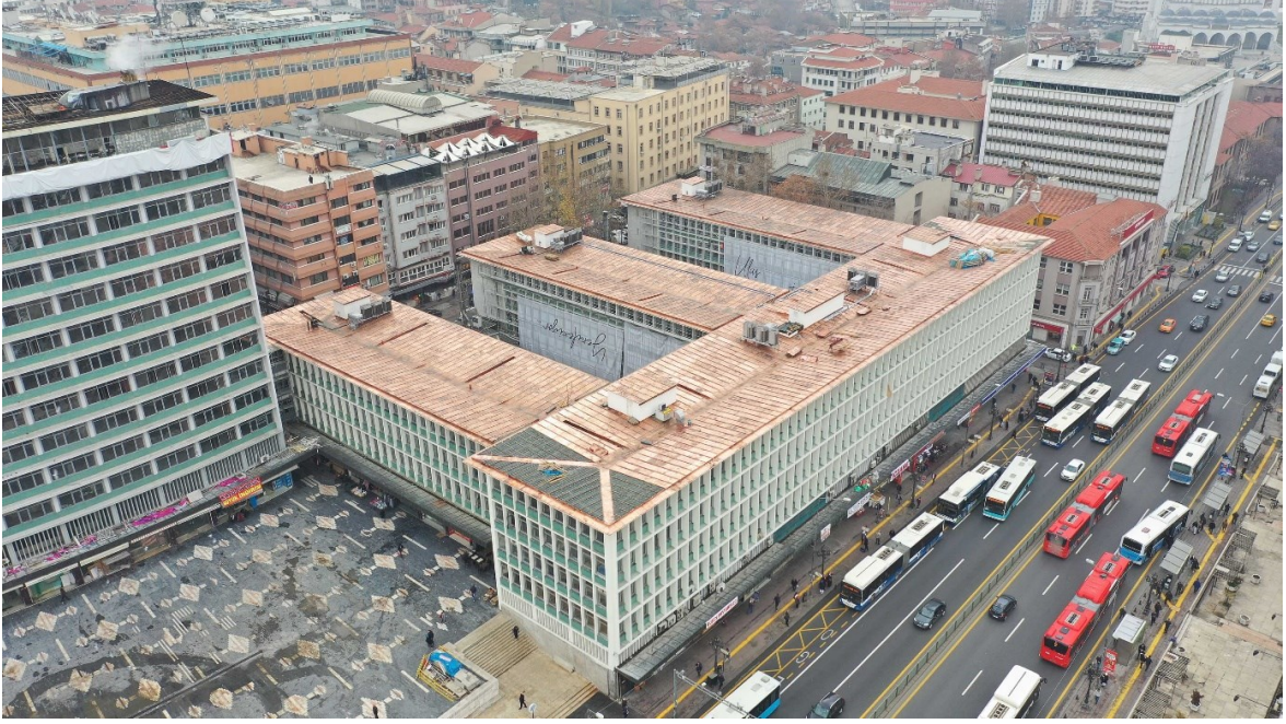
Resim 6.9. Ulus İş Hanı Restorasyon ve güçlendirme çalışmaları (43)
