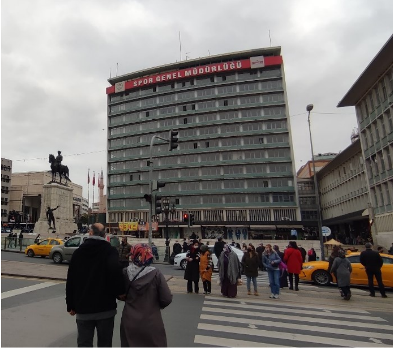
Resim 6.7. Gençlik ve Spor Bakanlığı binası tadilat öncesi hali
