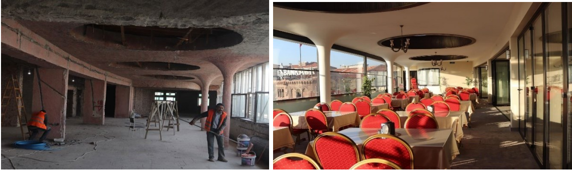
Resim 5.5. 2017 yılında tamamlanan restorasyon çalışmaları sırasında onarılan ve yemekhane olarak kullanılan bölüm, Strata Restorasyon firmasının ve ASBÜ arşivi
