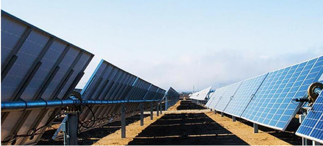
Őekil 4.4. Tracker sistem montaj örneęi (Yılmaz, 2023)
