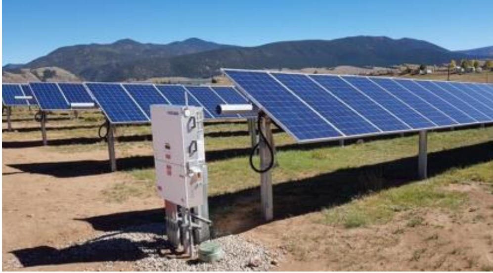
Şekil 3.15. İnvörtörün sahada montaj edilmiş hali
