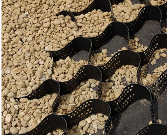
Şekil 2.8. Geocell uygulama örneği [20]
