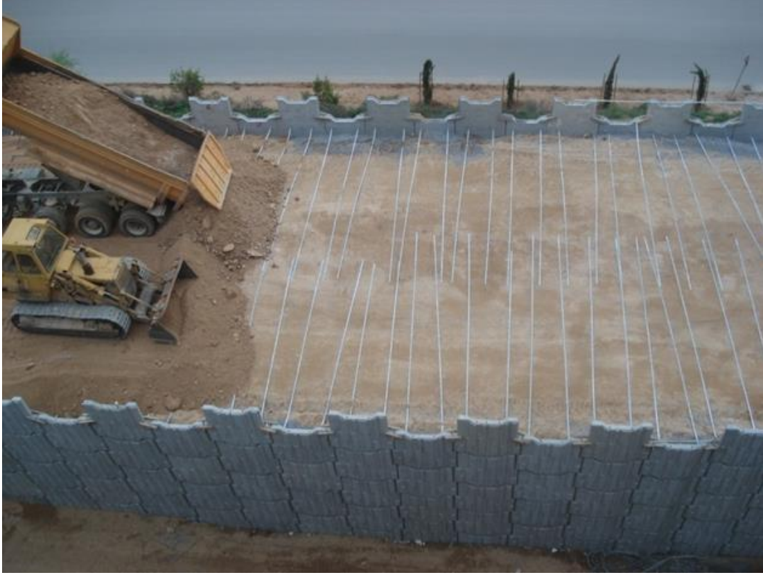
Şekil 3.2. Ön yüz panelleri kullanılarak ve çelik şeritlerle güçlendirilerek yapılan bir köprü yaklaşım dolgusu imalat aşamasından bir görünüm [34]
