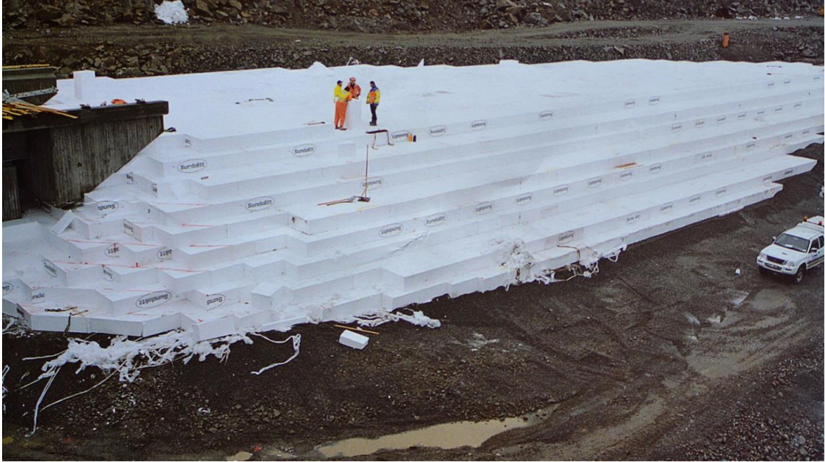
Şekil 2.9. Geofoam uygulama örneği [21]
