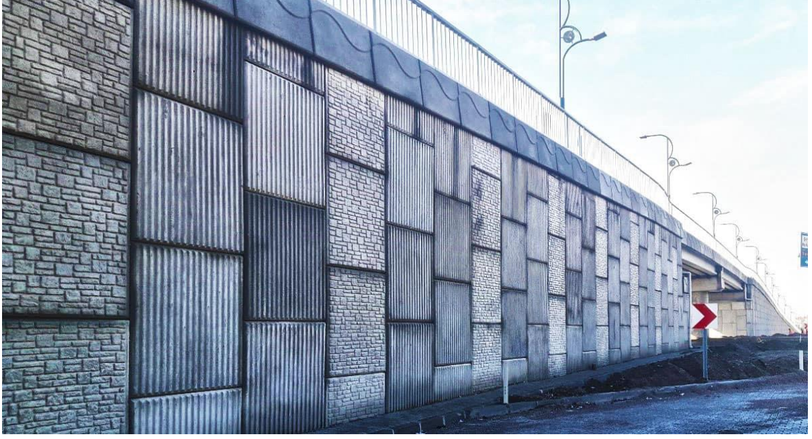
Şekil 3.3. Ön yüz panelleri kullanılarak çelik şeritlerle güçlendirilmiş köprü yaklaşım dolgusu örneği [35]
