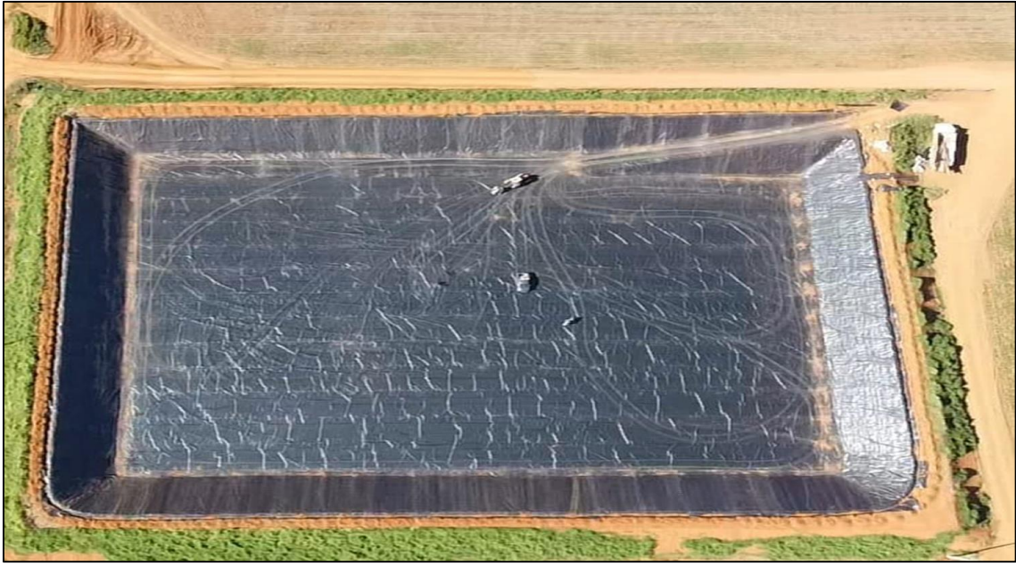
Şekil 2.5. Geomembran uygulama örneği [18]
