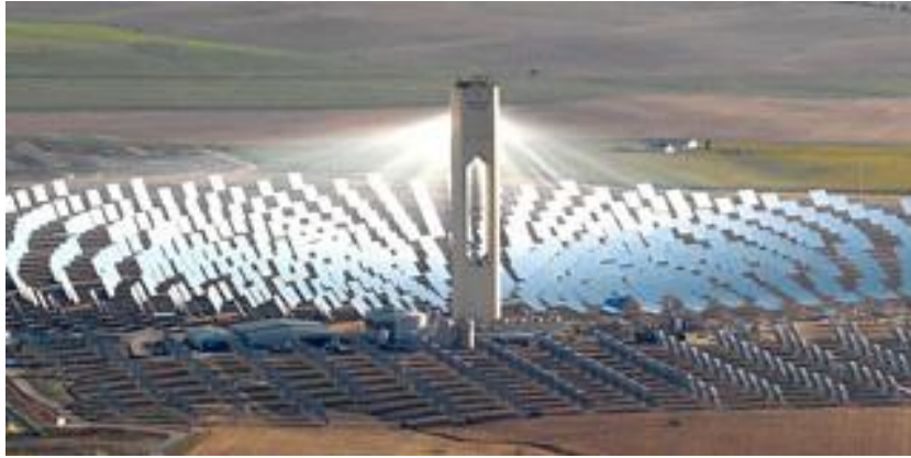
Şekil 2.1. Suyun yüksek sıcaklıkta termal parçalanması yaygın kullanımı aynalar ve odak noktası kule görünümü
