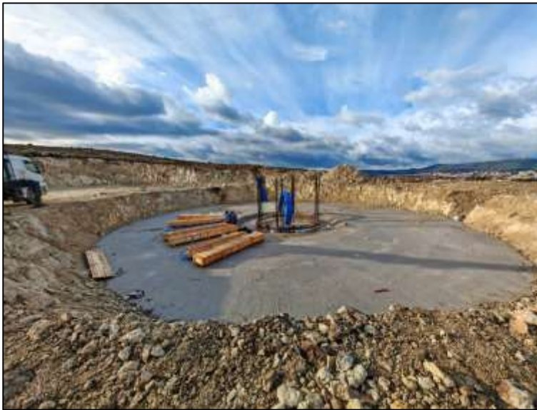
Şekil 3.17. Türbin temel atma aşamasından görüntü
