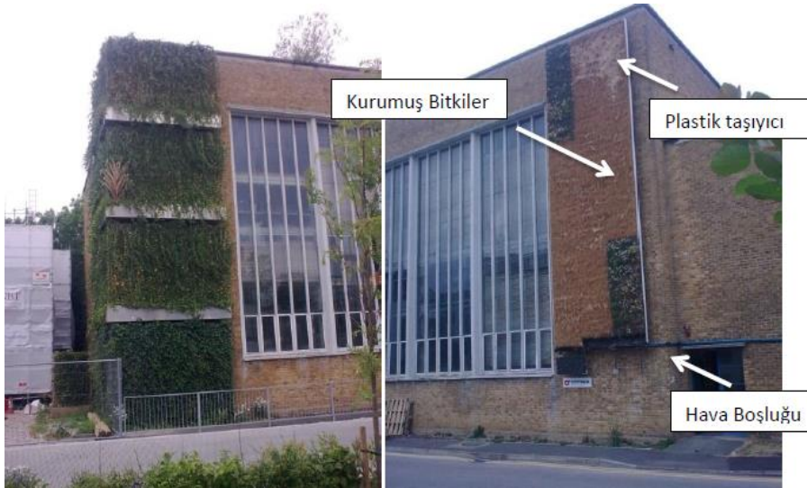
Şekil 2.5. Bitkilendirme sistemlerinde yangın riskleri [29]
