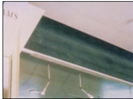
Resim 2.4. Duman perdesi uygulaması
