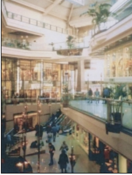
Resim 3.2. Atriumlarda, duman perdesi oluşturmak amacı ile uzatılmış balkon kirişi örneği (9)
